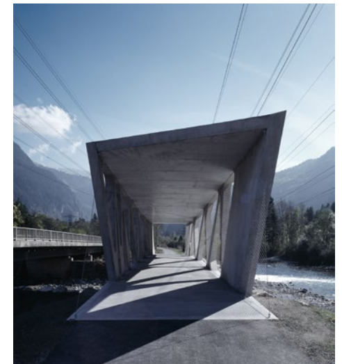
Tragwerk aus Beton: Die Alfenzbrücke (2005) in Vorarlberg von Marte. Marte Architekten, Foto: Marc Lins
