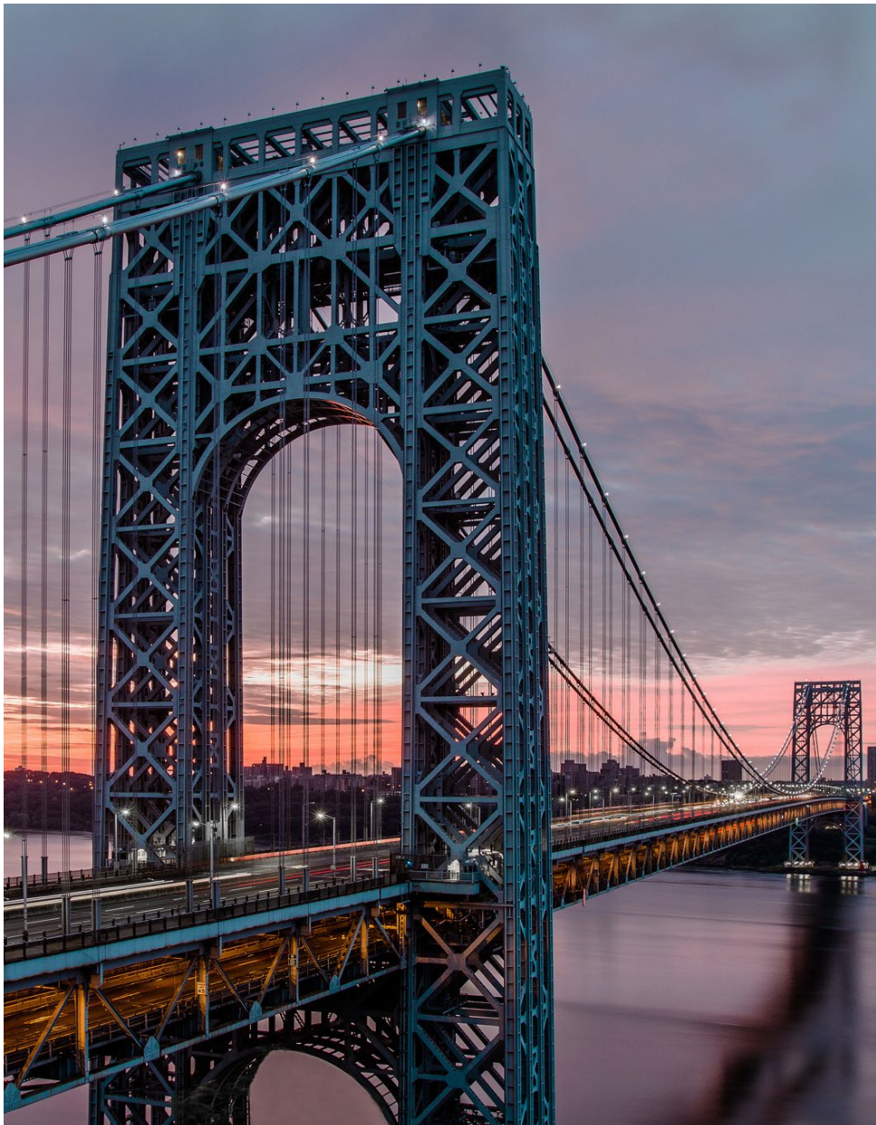
Laut Le Corbusier ein „Athlet“ und „schönste Brücke der Welt“: Die George-Washington-Brücke (1931) von Othmar Amman in New York City, eine 1.451 Meter lange Hängebrücke über den Hudson River.
