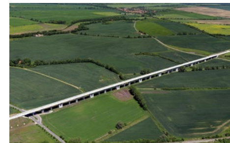
Foto: Deutscher Brückenbaupreis 2014, Gänsebachtalbrücke
