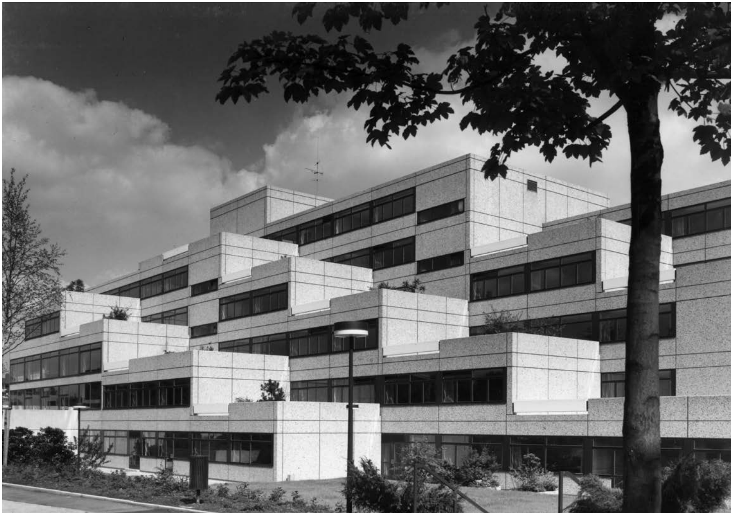
Haus der Erwachsenenbildung, Essen, gebaut 1969, bereits abgerissen, Foto 1971 (A:AI, Nachlass Wilhelm Seidensticker)
