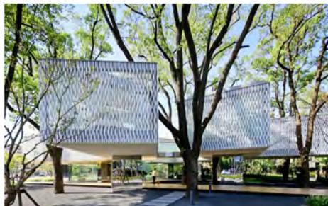
Weil sechs alte Kampferbäume im dicht bebauten Schanghai unbedingt erhalten bleiben sollten, erhoben Scenic Architecture das *Huaxin Business Center* auf Stahlbetonscheiben und Stahlstützen.
