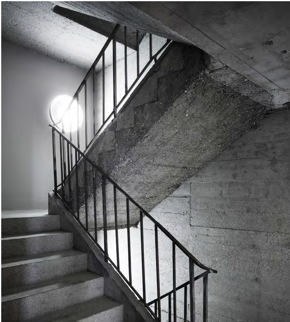
oben: Treppenhaus im Hochbunker München vor dem Umbau durch das Starnberger Büro raumstation Architekten, Foto: Christine Dempf für Euroboden rechts: Militärlhistorische Museum der Bundeswehr in Dresden von Daniel Libeskind, Foto: Hufton+Crow Photography
