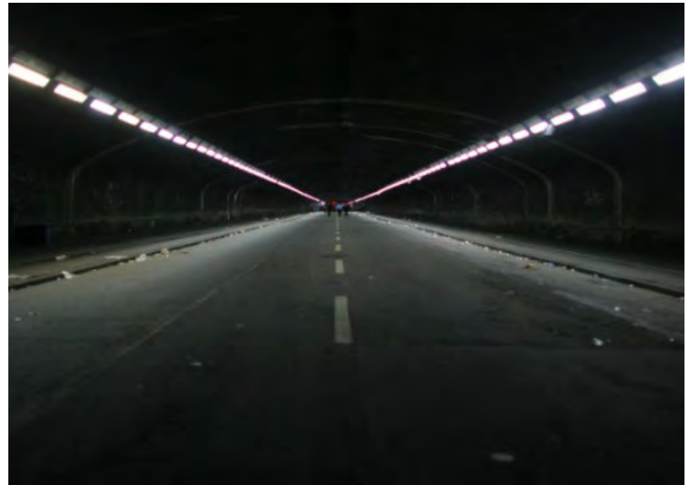
Der Tunnel in Duisburg, in dem 2010 während der Loveparade eine Massenpanik ausbrach
