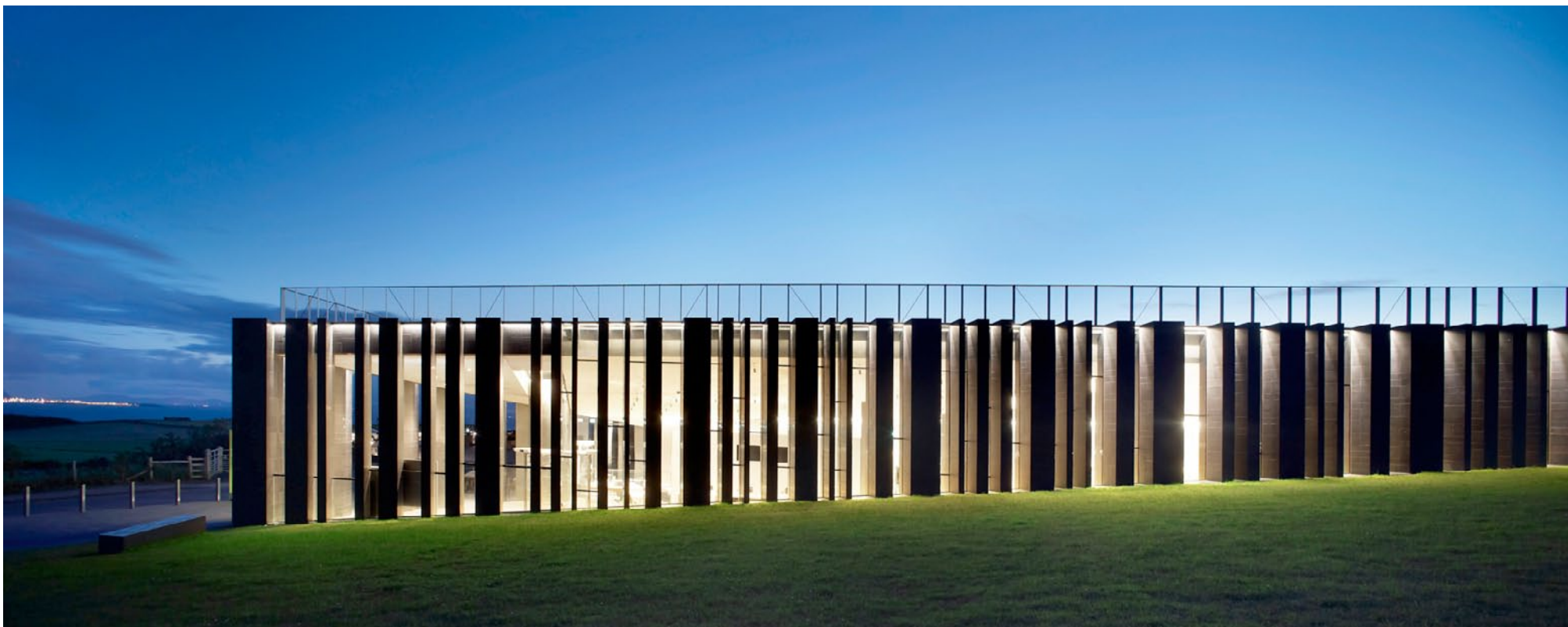
Das Gebäude geht nahtlos in die Landschaft über, versieht sie aber mit zwei geometrischen Falten. Ihre Frontflächen bilden die Basaltfassaden aus. Foto: Hufton + Crow
