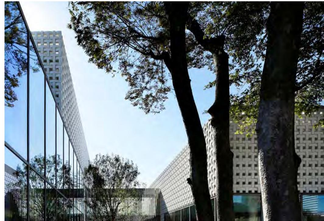
Unzählige Male wiederholt sich der Buchstabe T auf der Fassade eines noblen japanischen Medienkaufhauses – plastisch hervorgehoben durch glasfaserverstärkten Beton. Einblick in die Konstruktion und Fertigung der Gebäudehülle bietet das Architektur-Onlinelexikon [www.baunetzwissen.de](http://www.baunetzwissen.de)
