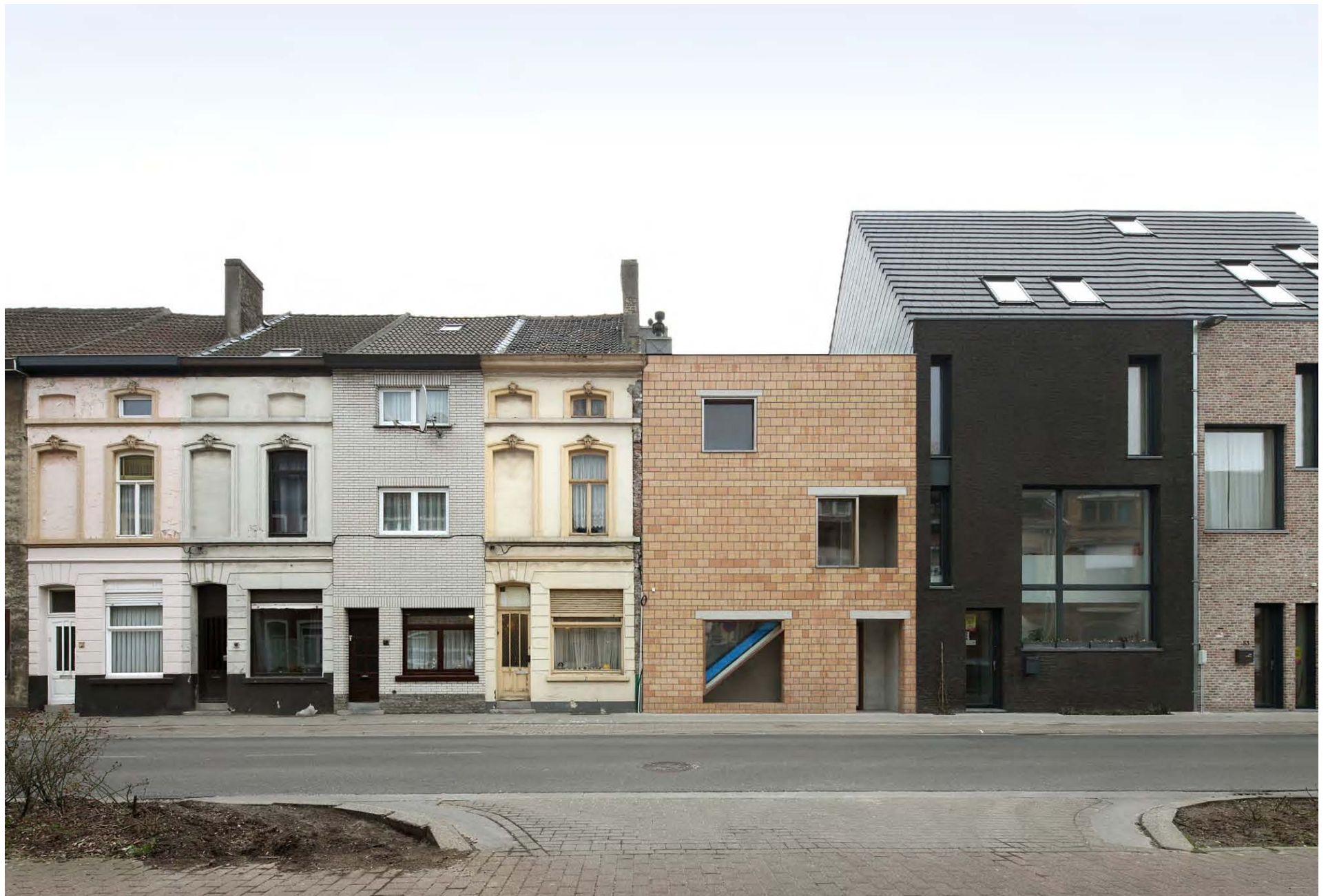
Das Haus Meulestede (2012) in Gent mit seiner Fassade aus unregelmäßigem Mauerwerksverband (Foto: Filip Dujardin)
