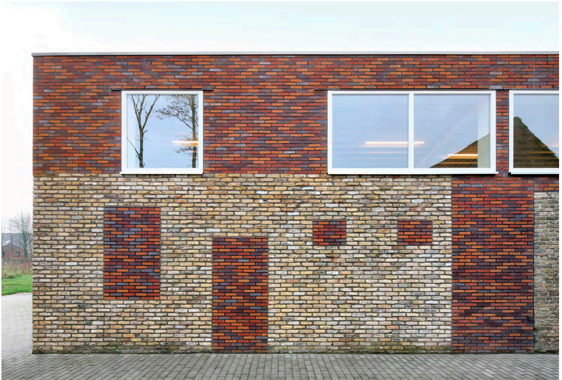
Backsteinspuren: Die Fassade des Bestandsgebäudes aus dem 19. Jahrhundert erzählt von zahlreichen Umbauten (Foto: Filip Dujardin)
