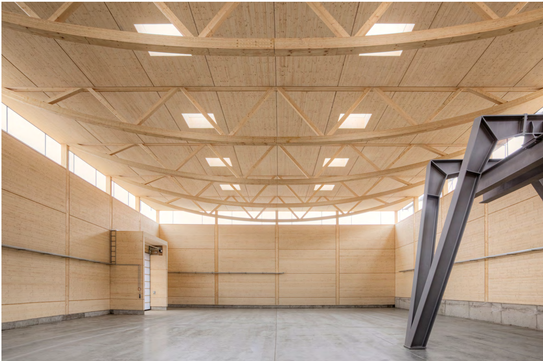
Werkhalle mit Fischbauchträgern von Ziegert Roswag Seiler (Foto: Daniela Friebe)
