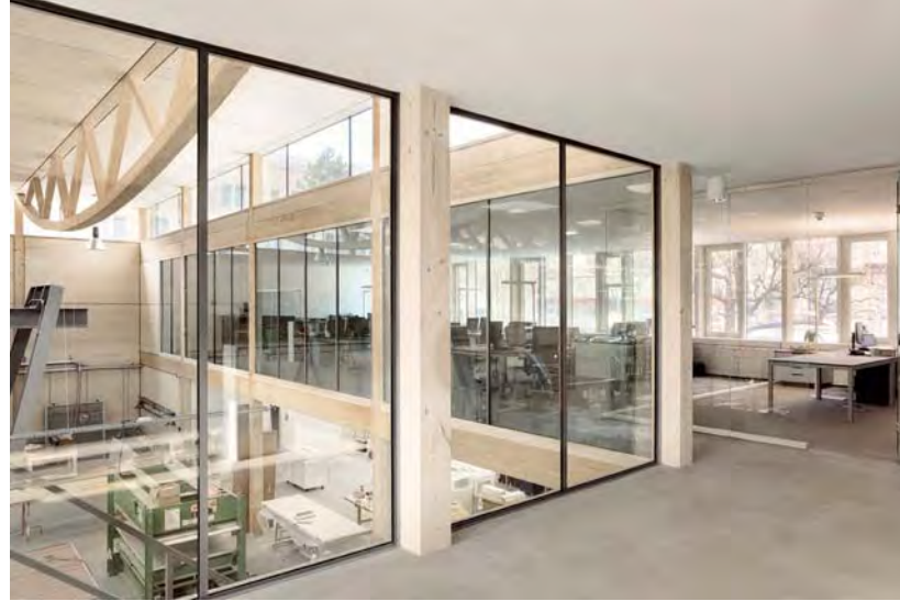
Außenwände und Dächer sind als hochwärmedämmende, diffusionsoffene Holzrahmenbauelemente mit eingeblasener Zellulosedämmung ausgeführt, und die Decken über dem Erdgeschoss sind aus Brettschichtholzelementen gefertigt. (Foto: Daniela Friebe)
