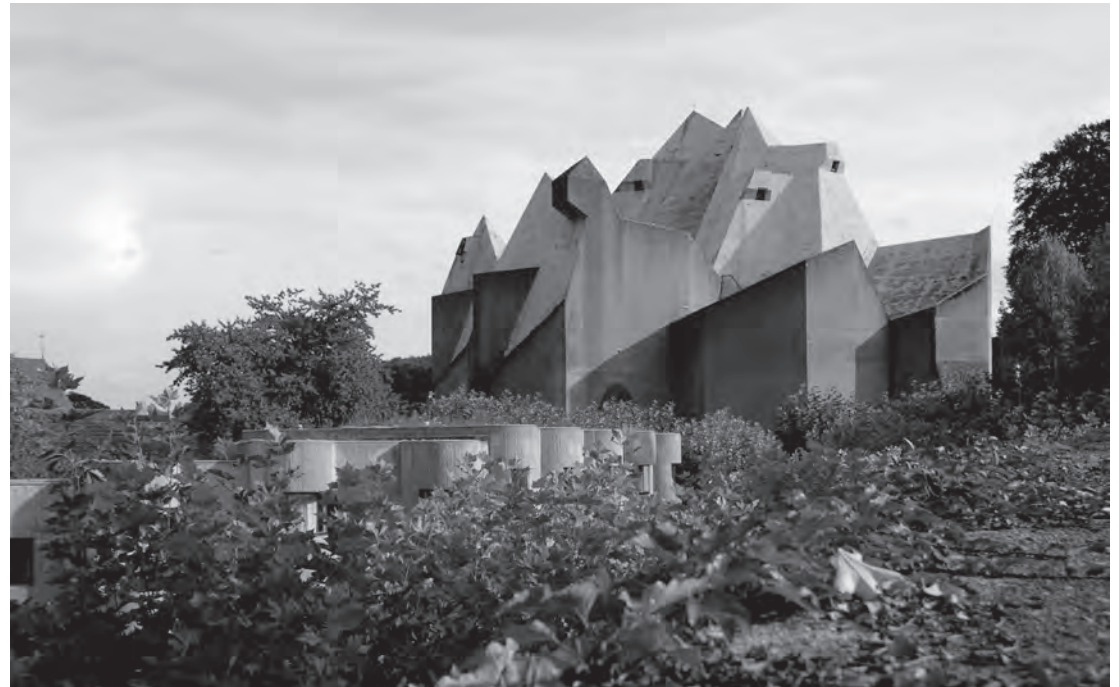
(Alb-)Traum in Beton: Das gewaltige Betondach von Gottfried Böhms Mariendom in Neviges war schon kurz nach seiner Fertigstellung 1968 ein Sanierungsfall. (Bilder: wikicommons)
