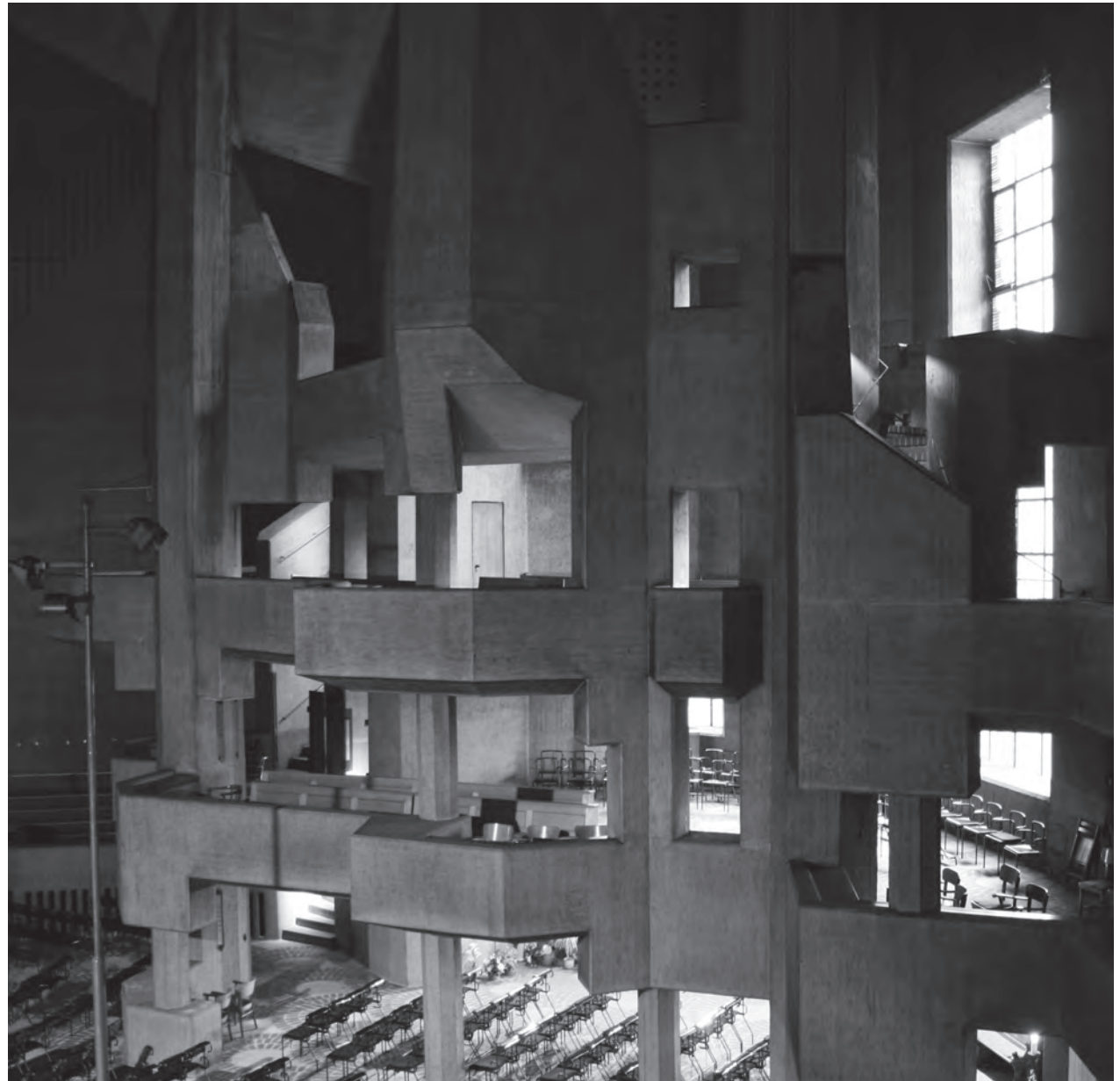
Innenraum des Wallfahrtsdom Neviges (Bild: wikicommons)
