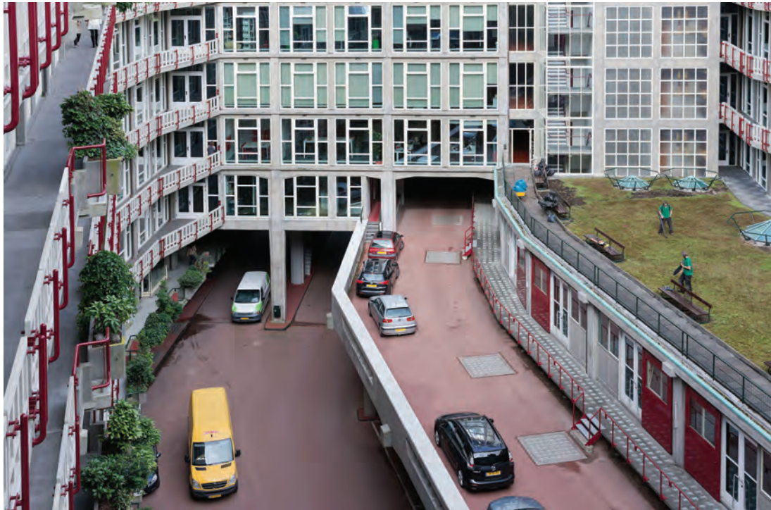
Hugh Maaskant: ‚Groot Handelsgebouw‘ in Rotterdam, 1953 (Foto: Iwan Baan, 2013)
