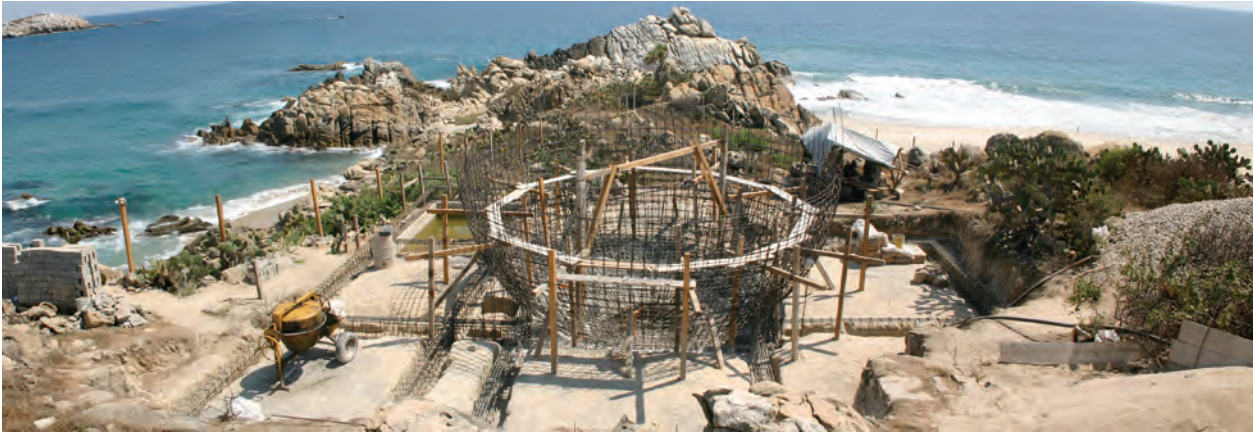
Das House Orozco entstand 2008 nach den Ideen und Entwürfen des mexikanischen Künstlers Gabriel Orozco; Bilbao war ausführende Architektin. Die Beulen der Innenwände resultieren aus der Dachmulde. (Fotos: Tatiana Bilbao)
