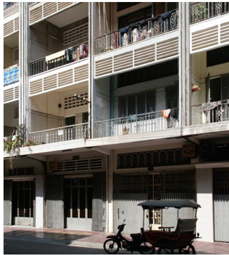
Foto oben: Phnom Penh besteht bis heute aus überwiegend drei- bis viergeschossiger Bebauung mit Wohn- und Geschäftshäusern
