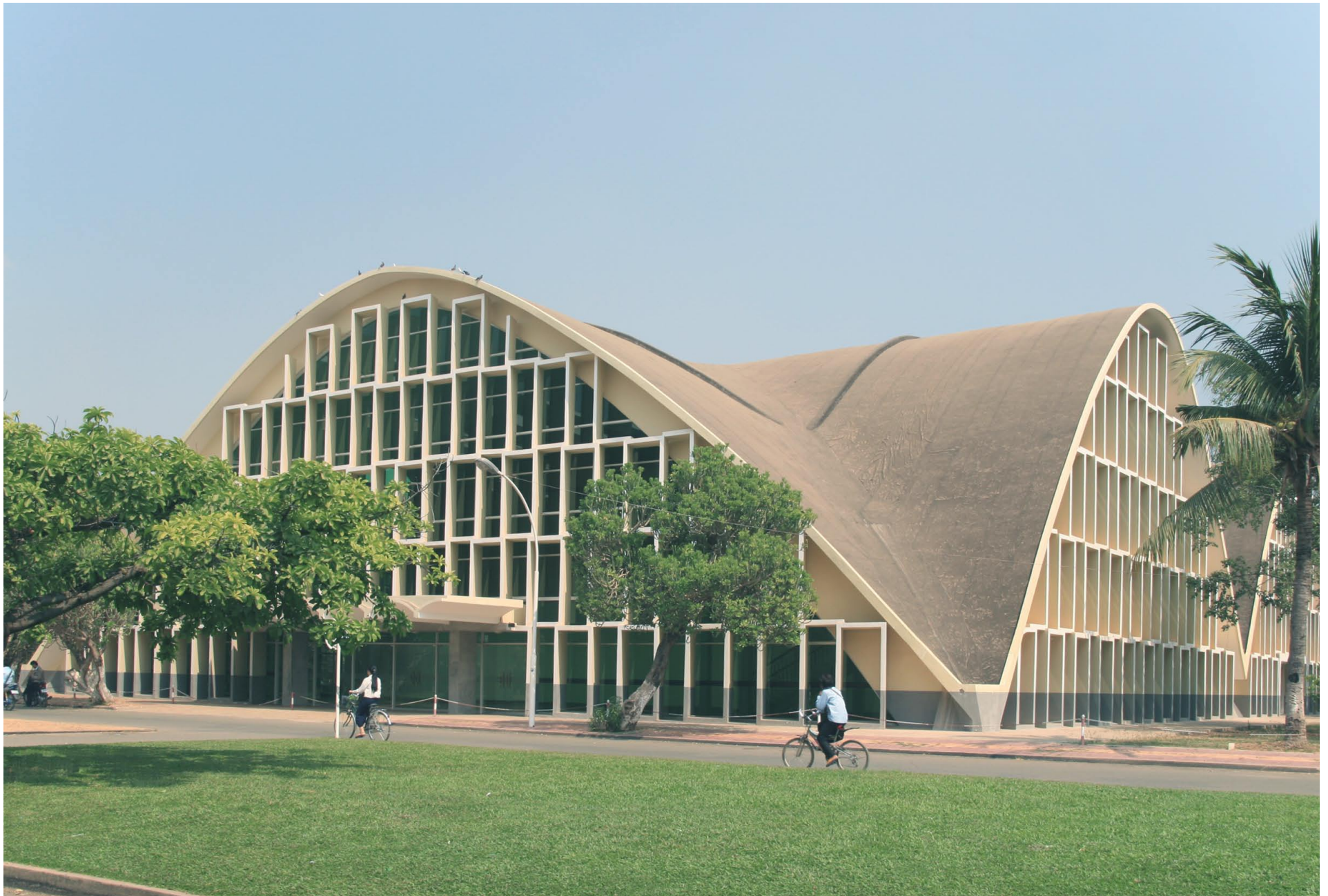
Eine Schalenkonstruktion und eingestellte Lamellen prägen die Versammlungshalle der Royal University of Phnom Penh .
