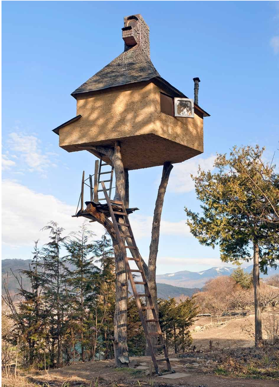
link: Das „Zu hohe Teehaus (2004)“ baute Terunobu Fujimori für sich selbst. Getragen von langen Baumstämmen, schwingt es manchmal mit der Bewegung seiner Gäste. Es steht in seinem Heimatdorf, vom Teeraum aus haben die Besucher einen Blick auf das Moriya Museum. Foto: Adam Friedberg
