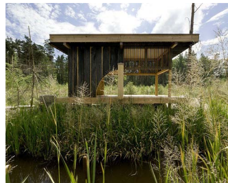
Bootshaus in Møre og Romsdal Schwarzes Teehaus in Česká Lípa
