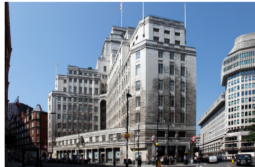
Hauptsitz Transport for London seit 1929, zugleich Station St. James' Park Foto: Thomas Spier
