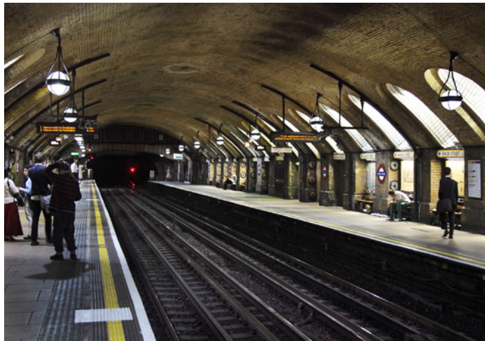
Baker Street: Foto eines Bildes aus dem London Transport Museum, eine der ersten Bahnsteighallen mit schräg eingesetzten Tageslichtschächten
