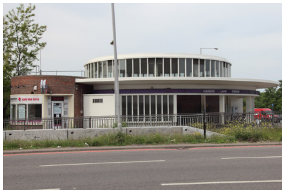
Bahnhofsgebäude Hangar Lane
