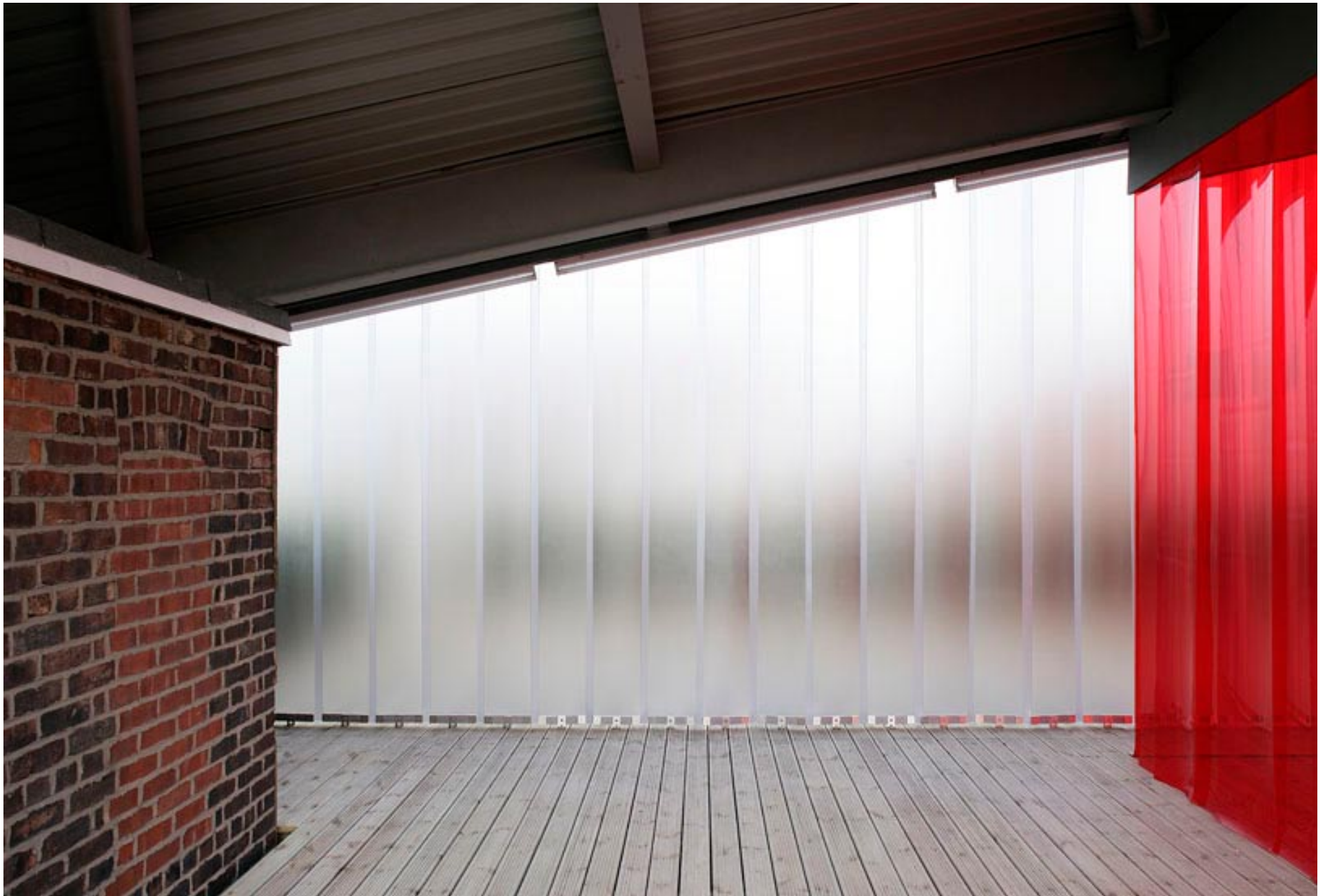
Kunsthalle LPL: die neue Dachkonstruktion liegt auf dem bestehenden Dachaustritt des Treppenhauses auf und setzt dessen Dachschräge fort. (Foto: Johannes Marburg)
