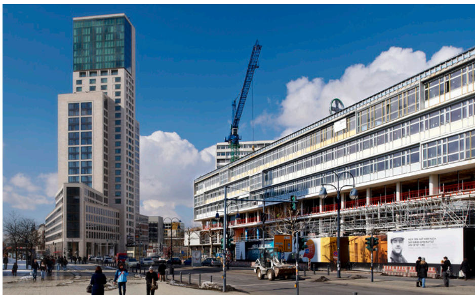
Bikini-Haus im Bau, Bayerische Hausbau, Foto: Franz Brück
