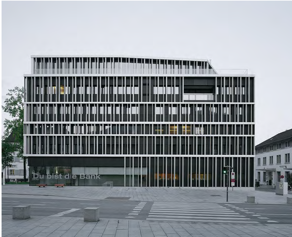
Als Beschattung und gestalterisches Element zugleich überlagern vertikale Drehläden aus eloxiertem Aluminium die bestehende Bandfassade. 630 Stück sind es insgesamt, zusammengefasst in 40 Steuermodulen, die vollautomatisch dem Sonnenstand folgen können. (Fotos: Rasmus Norlander)
