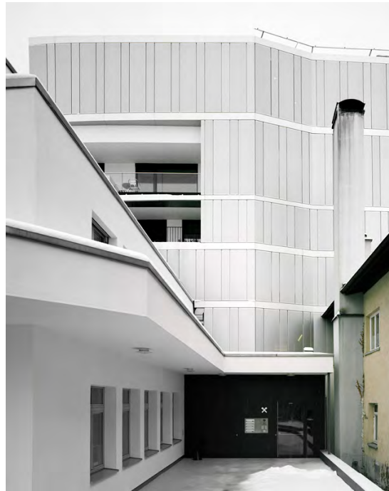
Von außen wirkt die Hülle opak, von innen ist durch die Perforation der Bleche eine Durchsicht nach außen möglich.
