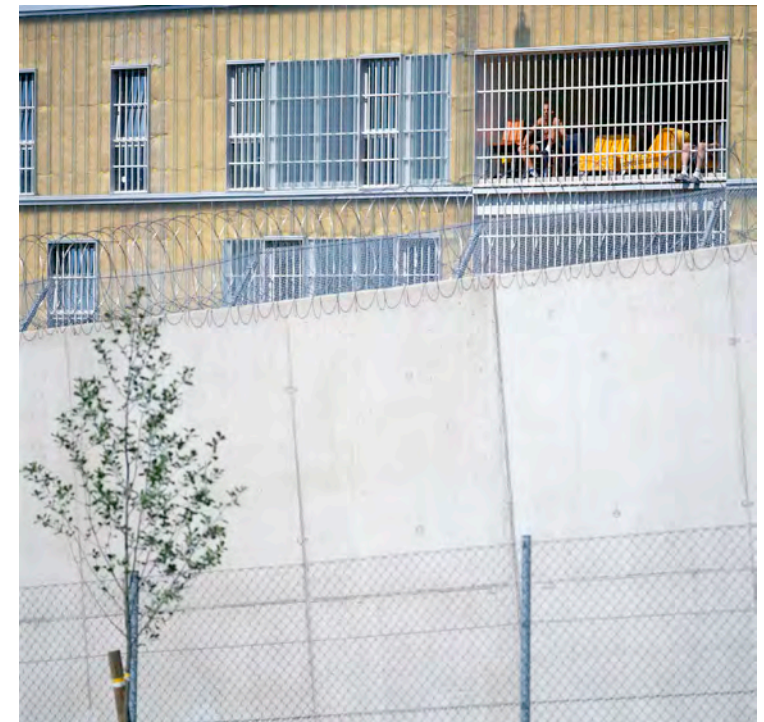
Justizzentrum Leoben in Österreich, Hohensinn Architektur, Foto: Paul Ott, Graz
