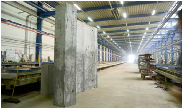
Prototyp Leichtbetonwand Foto: Barkow Leibinger Architekten
