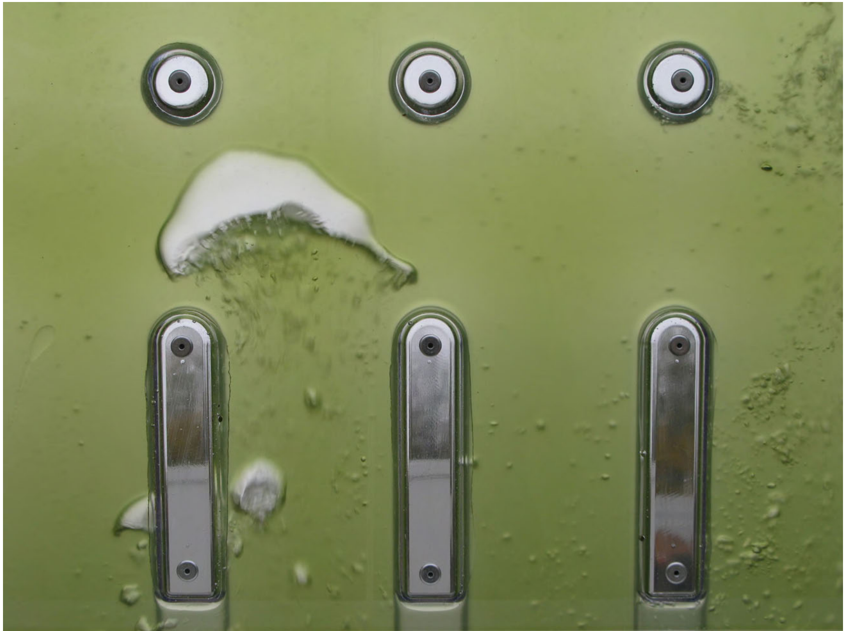
Detailansicht Photobioreaktor mit eingeleiteten Luftblasen, Arup Deutschland GmbH
