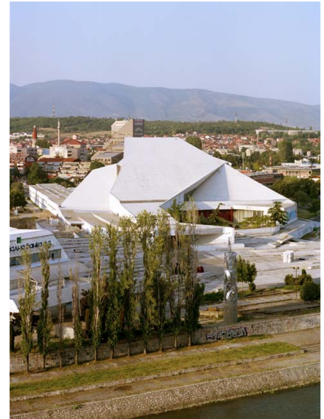
Die Mazedonische Oper in Skopje (1969-81) ist Teil des nur unvollständig umgesetzten Kulturzentrums nach Plänen von Štefan Kacin, Jurij Princes, Bogdan Spindler, und Marjan Uršič. Mit seinen „Falten“ aus Beton bildet das Gebäude einen urbanen Widerpart zu den Bergen. Die Oper markierte das Ende der Moderne in Skopje. (Fotos: Wolfgang Thaler)
