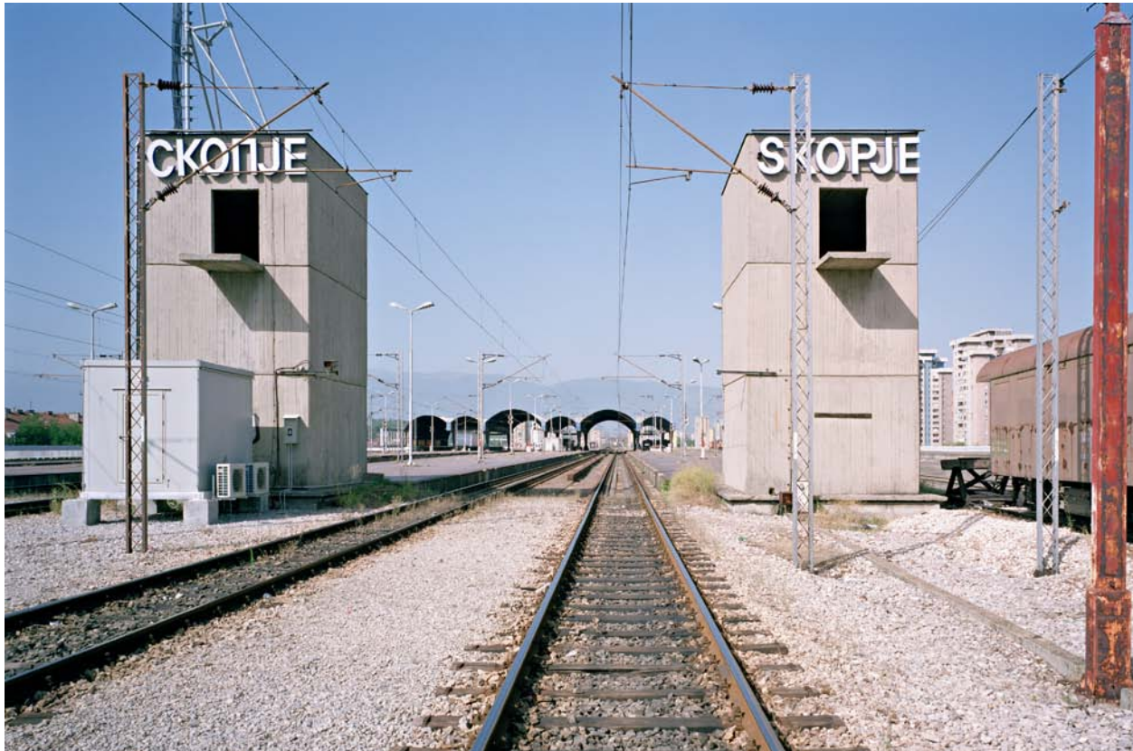
Kenzo Tange: Bahnhof, Skopje, 1968. Nach dem Erdbeben von 1963 entwarf Tange den Masterplan für Skopje. Der Einfluss von Architekten wie Tange und Louis Kahn förderten die Verbreitung des Brutalismus in den 1960er Jahren. Tanges Projekt einer „Stadtmauer“ blieb unvollendet: Von dem „Stadtter“ wurde lediglich die Bahnstation umgesetzt; sie ist jedoch kaum noch von Bedeutung.
