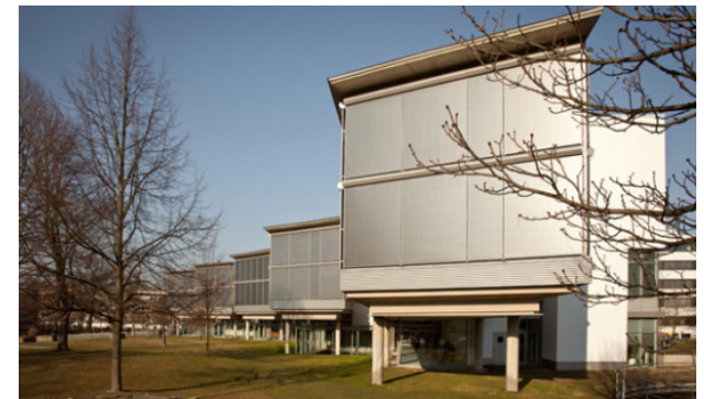
Sanierung der Unibibliothek in Göttingen
