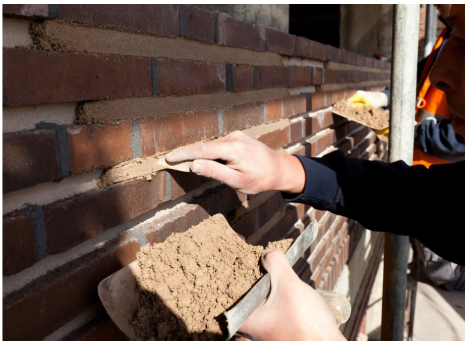
Neuerfugen mit zwei Mörtelfarben
