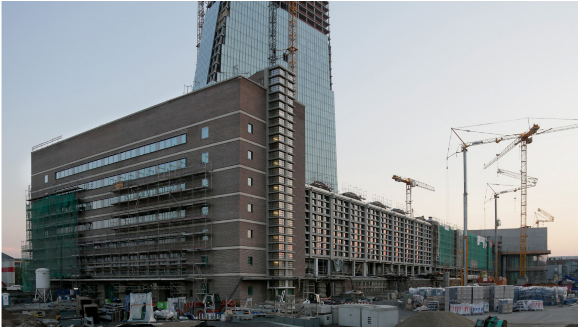
Die Frankfurter Großmarkthalle, dahinter der Doppelbüroturm im Bau (Foto: European Central Bank/Robert Metsch)
