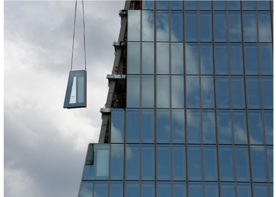
Montage der Fassadenelemente an der Gebäudekante (Fotos: European Central Bank/Robert Metsch)
