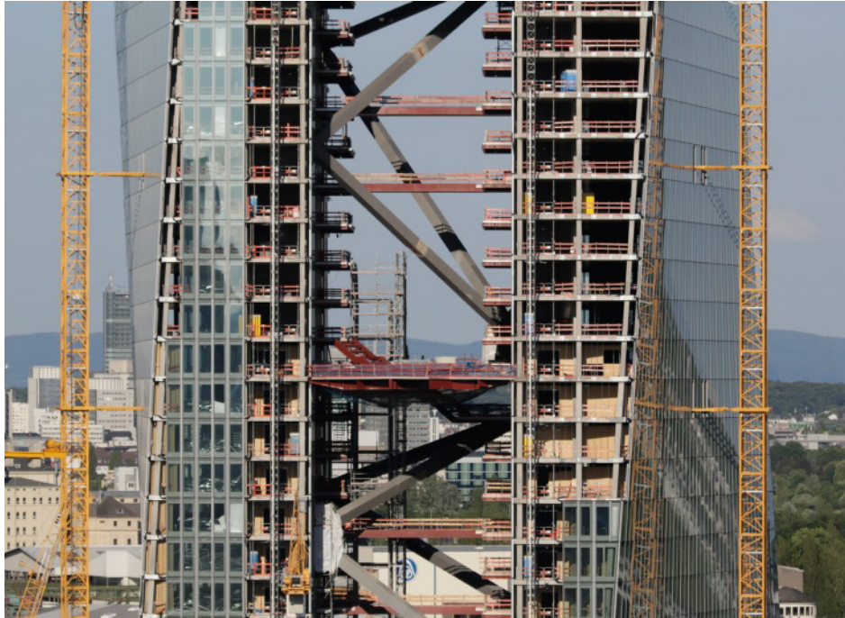
Blick auf eine der Verbindungsplattformen
