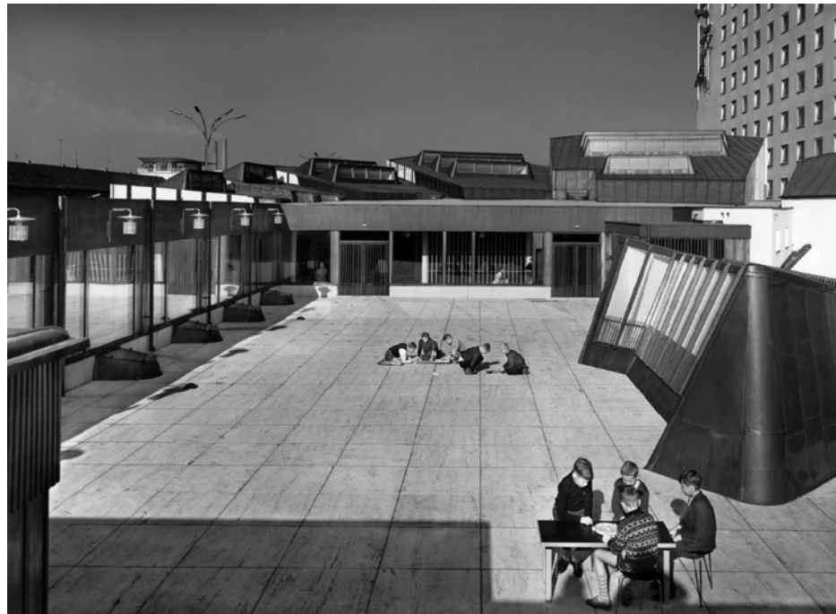
Das Dach hat Alvar Aalto wie bei vielen seiner Bauten als fünfte Fassade geplant: Hier sollte ebenso ein Treffpunkt für die Nutzer des Kulturhauses entstehen, der auch für die Öffentlichkeit zugänglich sein sollte. Früher war die Dachterrasse eine Spielwiese für das Jugendzentrum (Foto: Heinrich Heidersberger, 1962)
