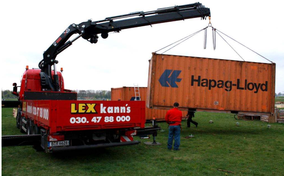
Die Drehfundamente für die Container werden eingebaut, Zunkunftsgeräusche GbR
