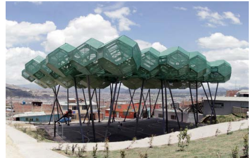
Sportfeldüberdachung in Bogota / CO
