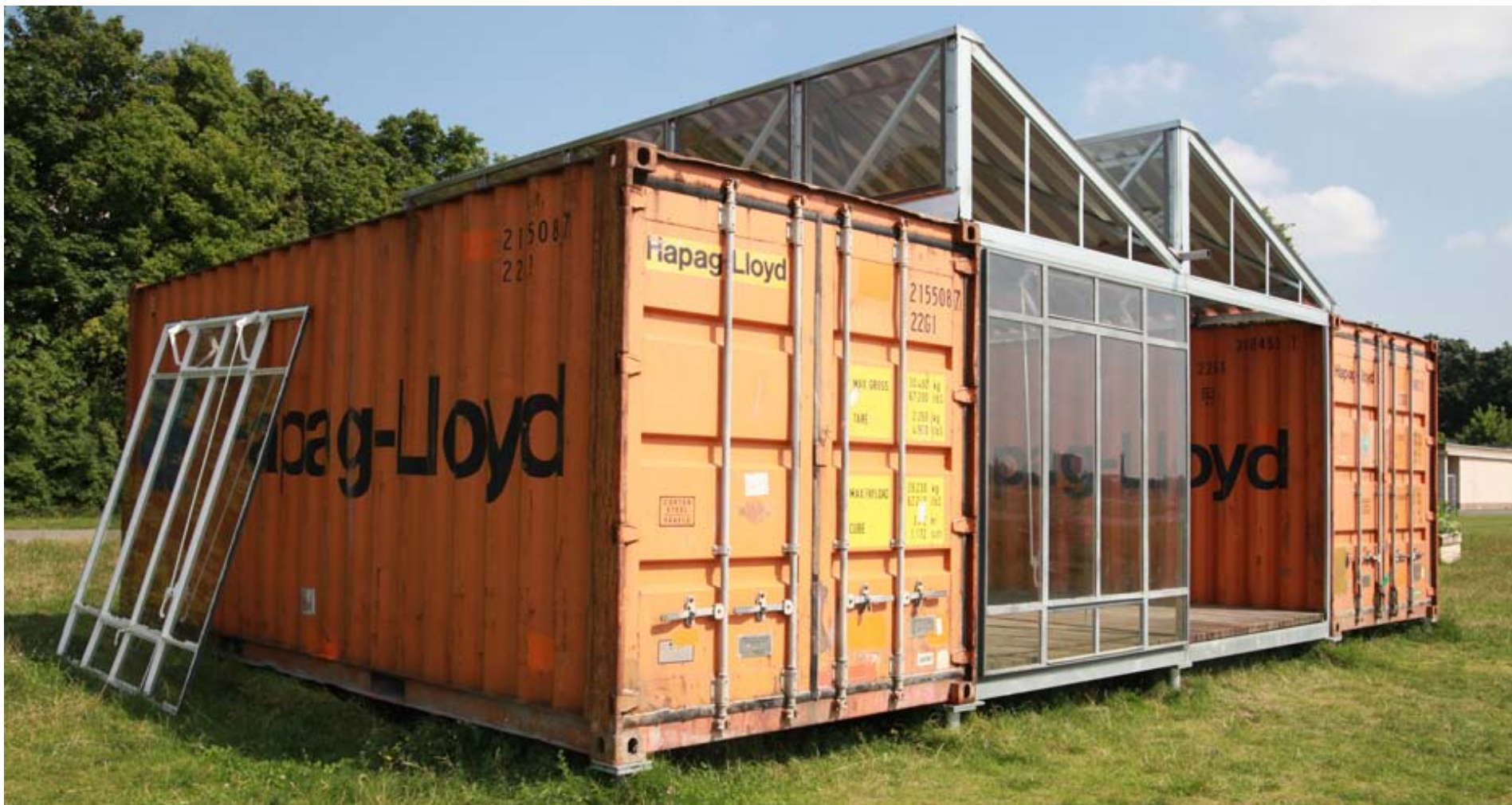
Bauhaus re use Pavillon auf dem Tempelhofer Feld, Zukunftsgeräusche GbR
