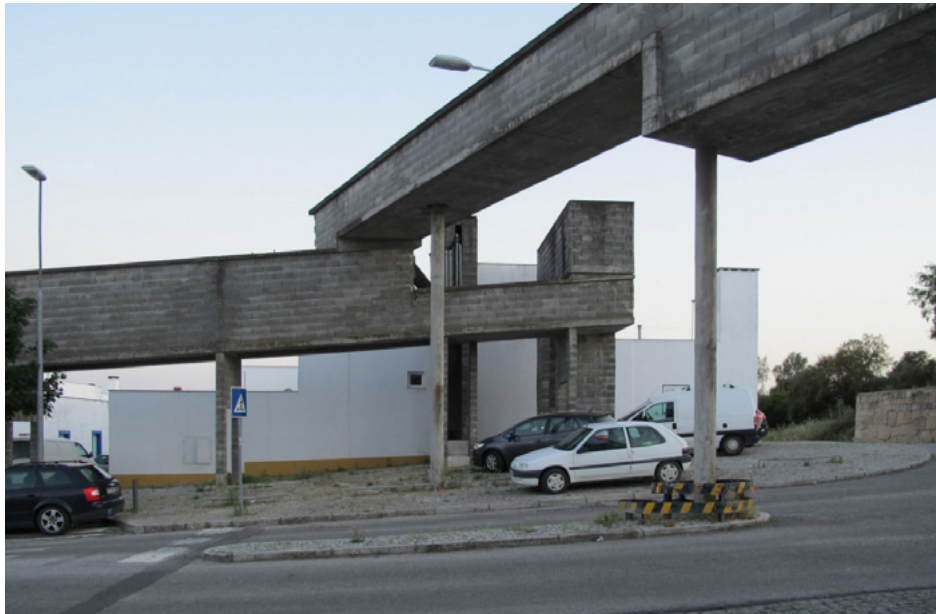
Malagueira, Viadukte am Rand der Siedlung „in widerspenstiger Eigenständigkeit“: Siza adaptierte hier das Motiv des örtlichen römischen Aquädukts für die Führung der Versorgungsleitungen
