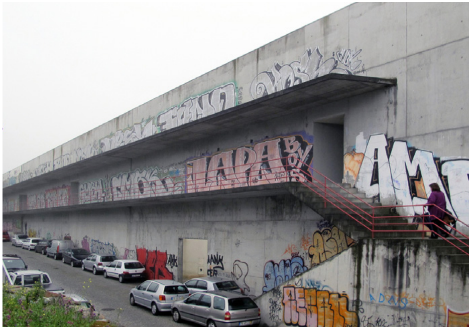
Bouça, Wand zum Bahnkörper und Durchgang in der Lärmschutzwand
