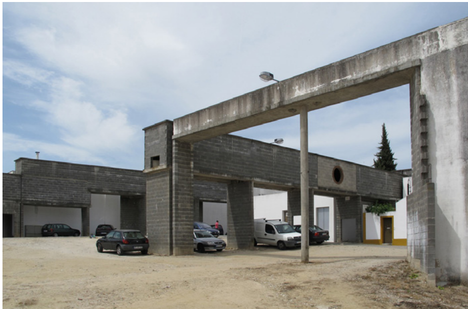
Malagueira, Viadukte am Rand der Siedlung „in widerspenstiger Eigenständigkeit“: Siza adaptierte hier das Motiv des örtlichen römischen Aquädukts für die Führung der Versorgungsleitungen
