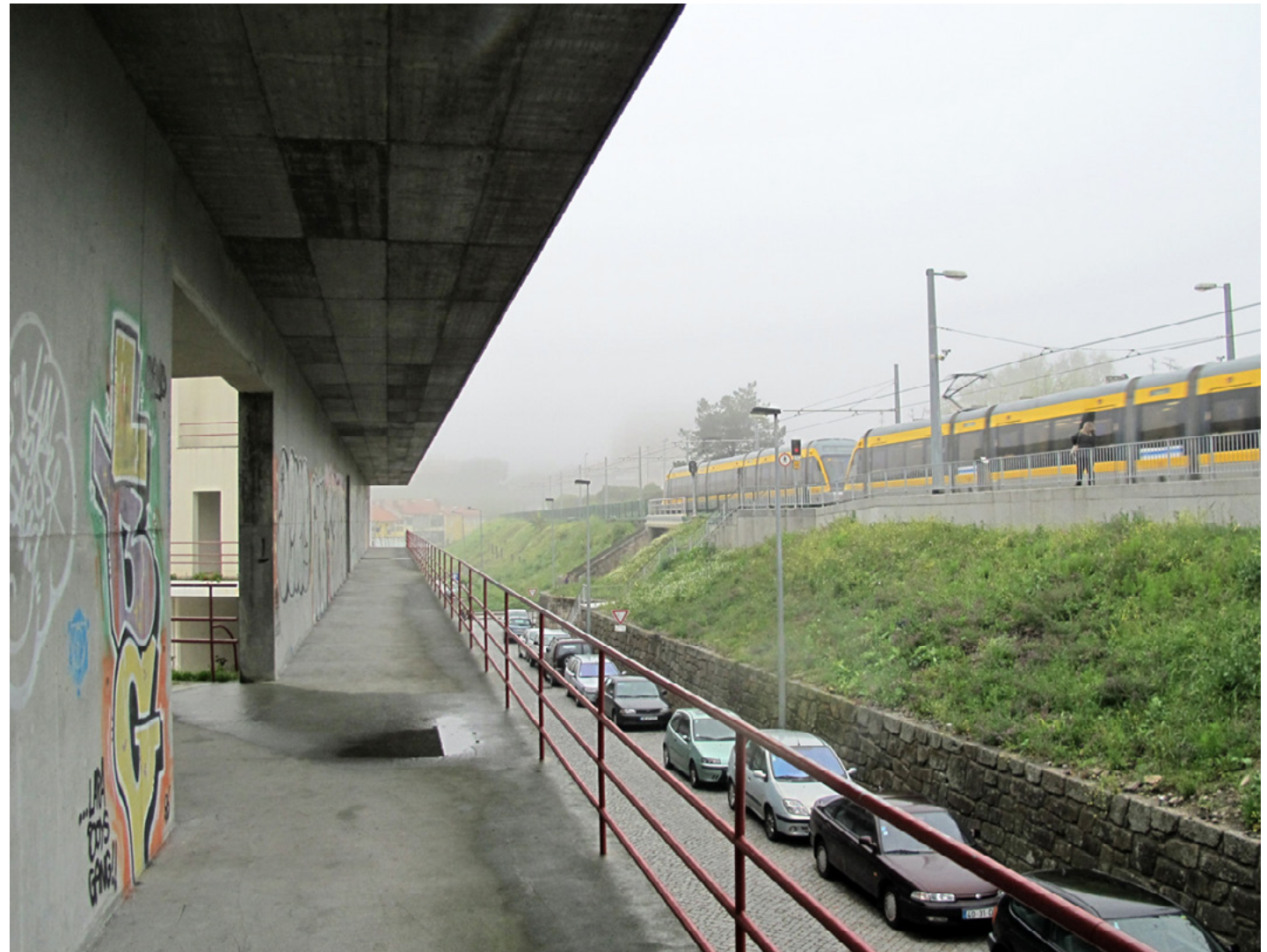
Bouça, Ansicht Wand zum Bahnkörper. Die Lärmschutzwand gehörte zum Konzept der Siedlung von 1975, wurde aber erst 2006 mit dem zweiten Bauabschnitt errichtet. Alle Foto, wenn nicht anders angegeben: Veronika Brugger, Mai 2012
