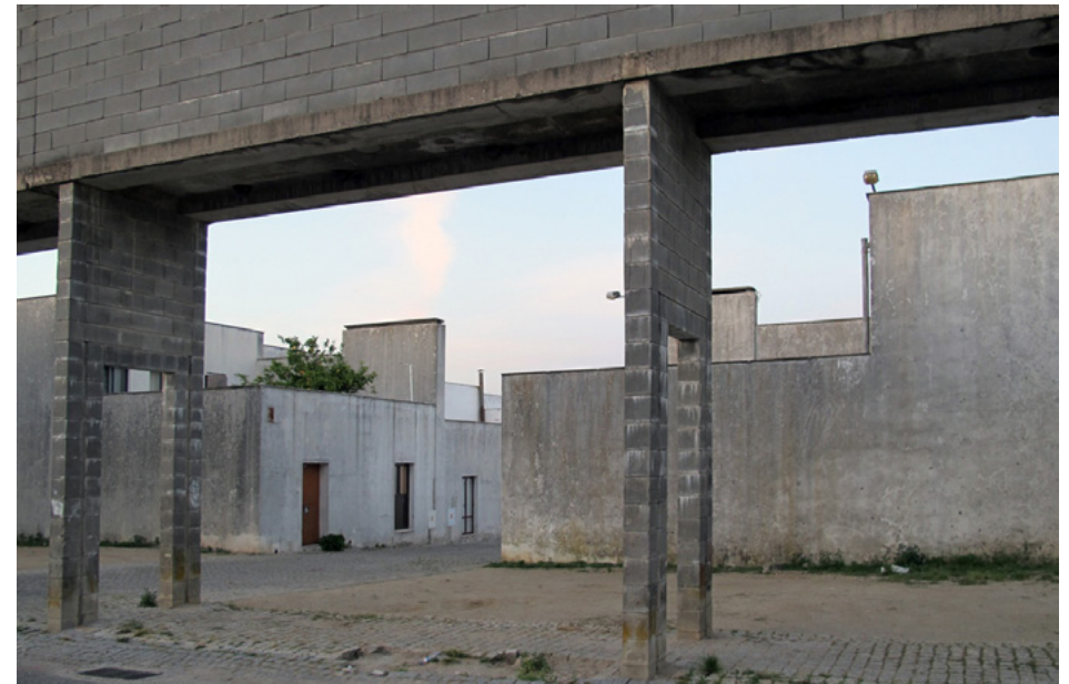
Malagueira, Viadukte am Rand der Siedlung „in widerspenstiger Eigenständigkeit“: Siza adaptierte hier das Motiv des örtlichen römischen Aquädukts für die Führung der Versorgungsleitungen
