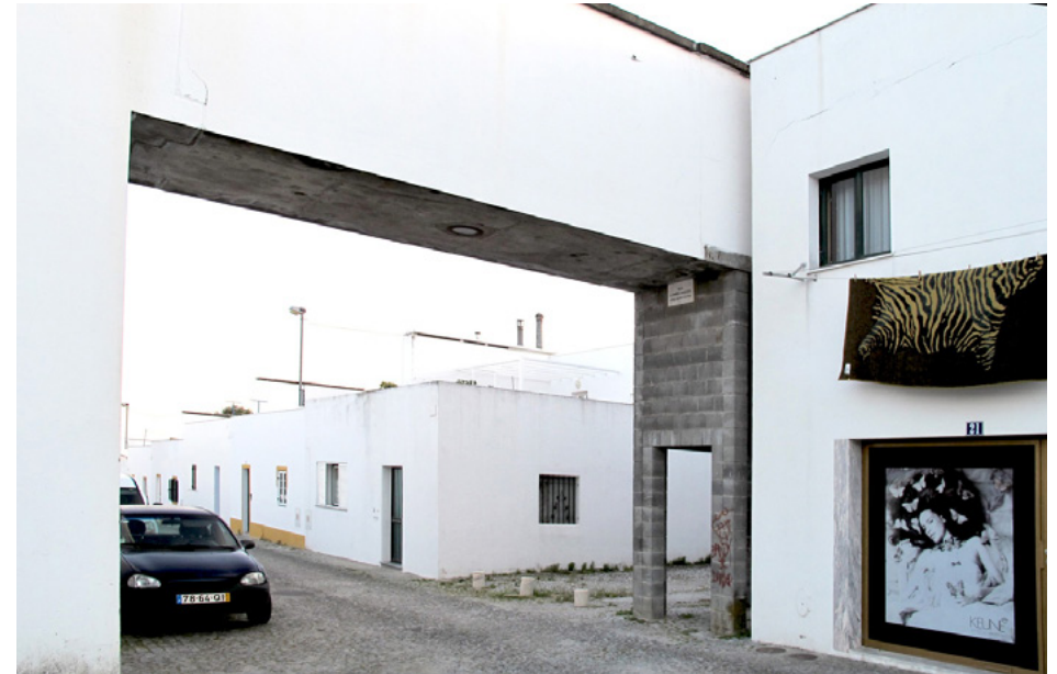
Malagueira, Viadukte am Rand der Siedlung „in widerspenstiger Eigenständigkeit“: Siza adaptierte hier das Motiv des örtlichen römischen Aquädukts für die Führung der Versorgungsleitungen
