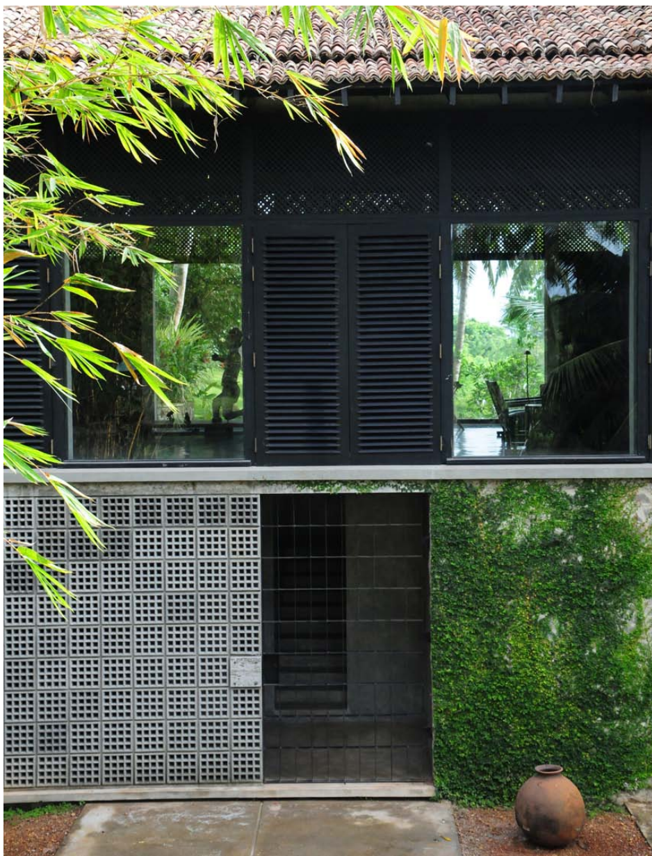
In der Fassade des Black Pavilions sorgen sogenannte Breeze Blocks dafür, dass die Räume im heißen Klima angenehm kühl bleiben. Weitere Materialien sind Stein, Holz und recycelte Lehmfliesen. Fotos: Justin Hill
