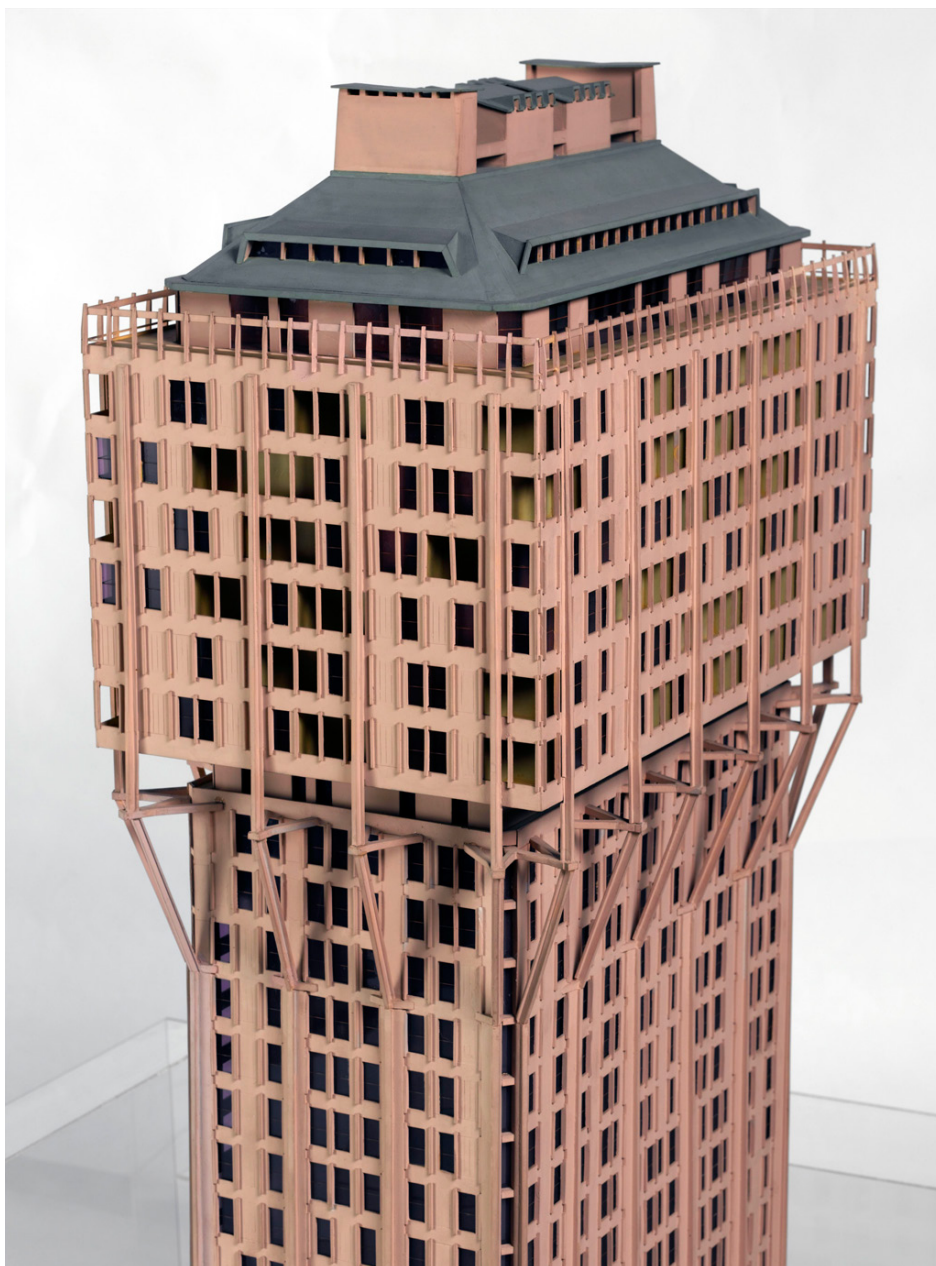
BBPR – Torre Velasca, Milan, Lombardie (1950-1958) Foto: Philippe Migeat / Georges Meguerditchian © Arch. Prof. Alberico Barbiano di Belgiojoso
