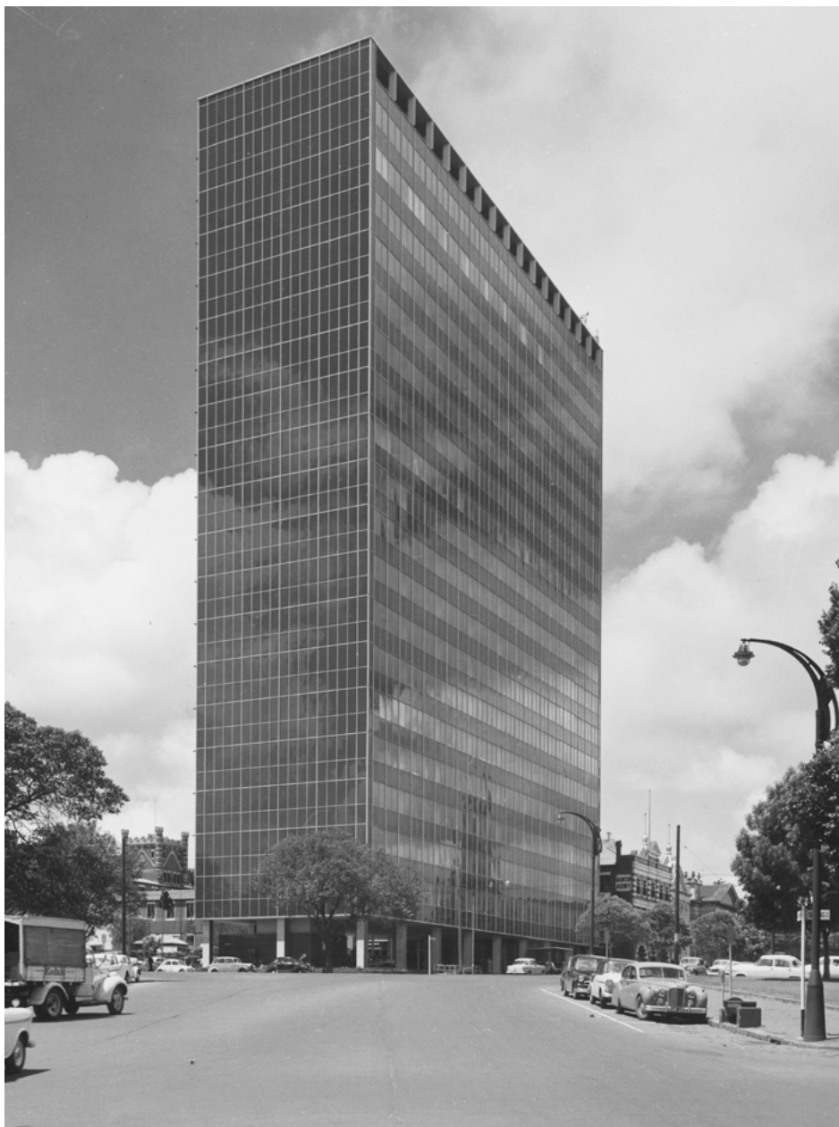
ICI House (heute: Orica House), East Melbourne, Architekten: Bates, Smart & McCutcheon, 1955-58 Foto: Wolfgang Sievers, 1958
