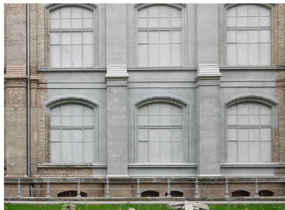
Diener & Diener Architekten. Ostflügel Museum für Naturkunde, Berlin. Der kriegsbeschädigte Flügel wurde sorgfältig ergänzt, die Fehlstellen wurden mit Betonfertigteilen ausgefüllt, für die die Textur der alten Fassade sorgfältig nachgegossen wurde – ein „Recycling der vorhandenen Form“. (Fotos: RRR / German Pavilion 2012)
