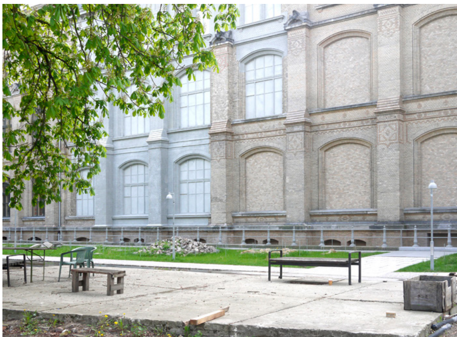
Diener & Diener Architekten. Ostflügel Museum für Naturkunde, Berlin. Der kriegsbeschädigte Flügel wurde sorgfältig ergänzt, die Fehlstellen wurden mit Betonfertigteilen ausgefüllt, für die die Textur der alten Fassade sorgfältig nachgegossen wurde – ein „Recycling der vorhandenen Form“. (Fotos: RRR / German Pavilion 2012)
