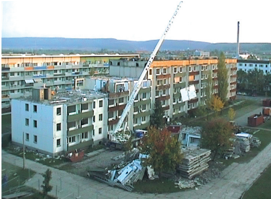
Leinefelde Physikerquartier von msp meier-Scupin & Petzet, Mayr, Hehenberger: Demontage der oberen Stockwerke eines Wohnblocks
