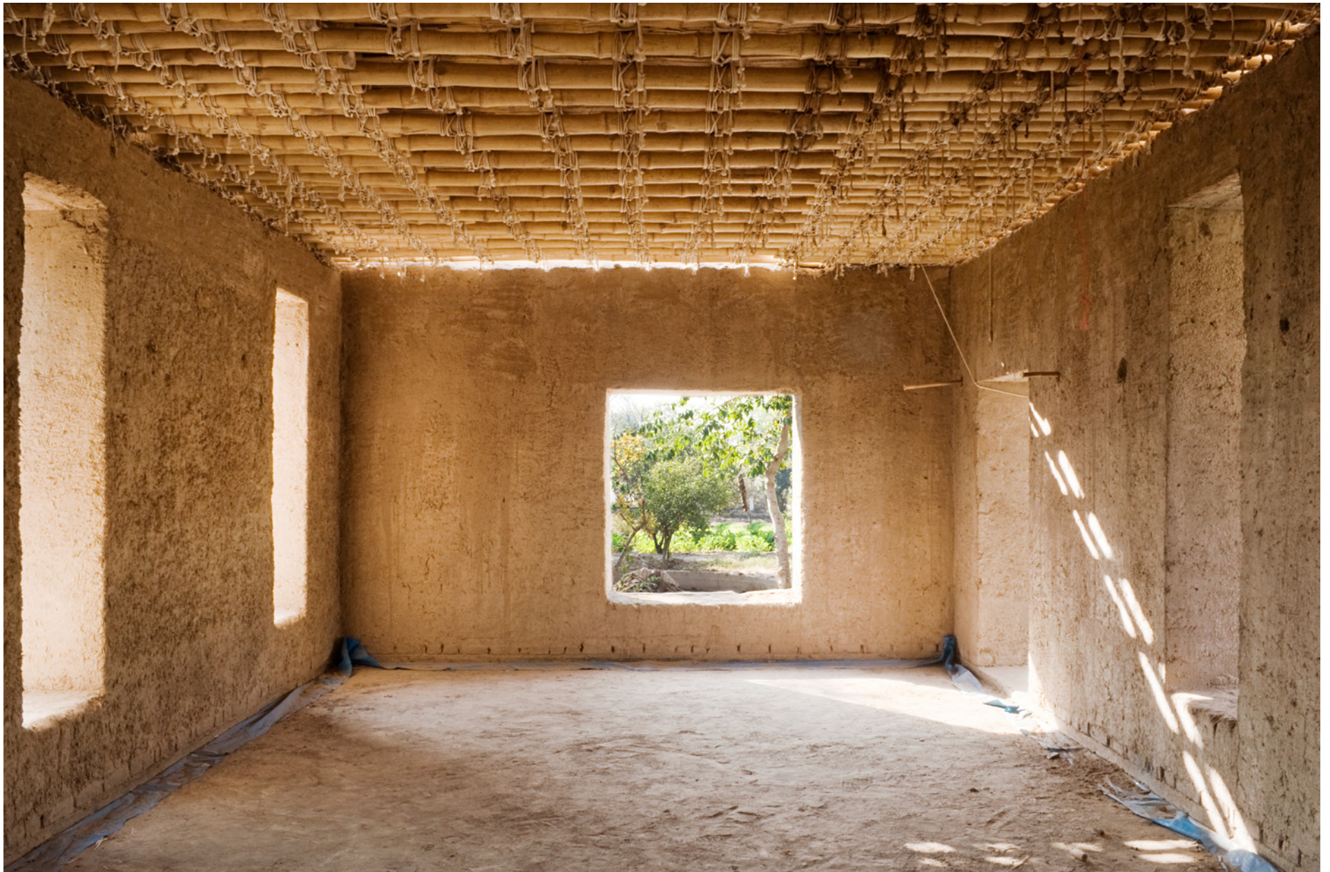
Im Bau: Das Erdgeschoss der Lehmschule in Pakistan von Ziegert Roswag Seiler Architekten + Ingenieure (Foto: Roswag Architekten)
