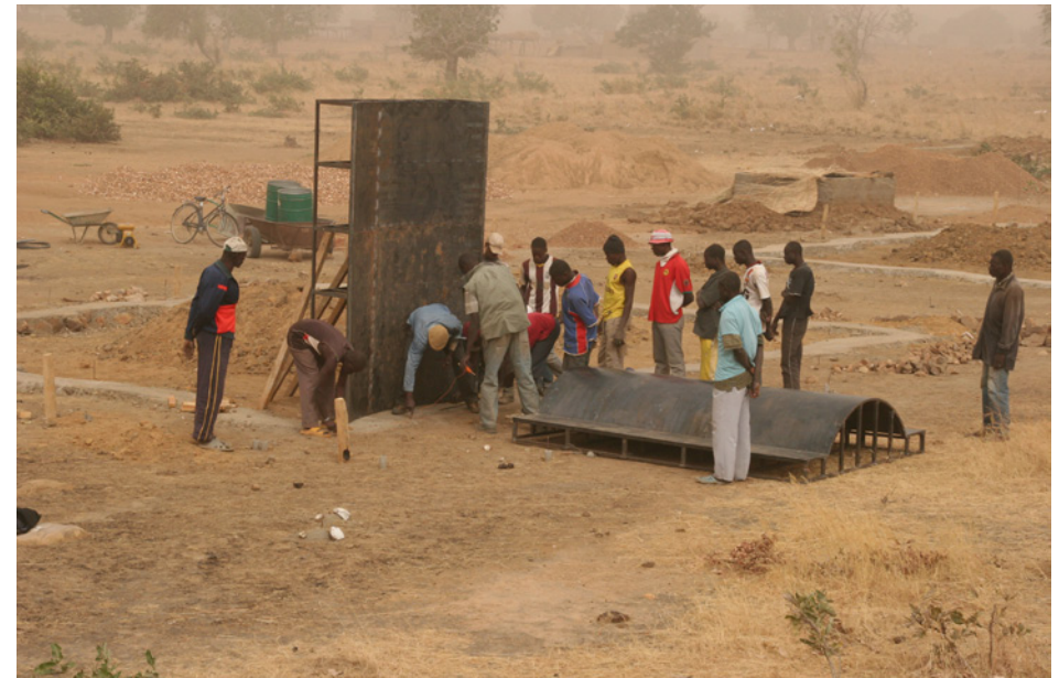
Lehm stampfen und pressen war gestern: Durch die leichte Rundung sind die einzelnen Wandelemente aus Lehm in sich stabil und ausgesteift. Hergestellt werden sie mit Hilfe eines zweiteiligen Schalungsmoduls aus Eisen. (Fotos: Francis Kéré)
