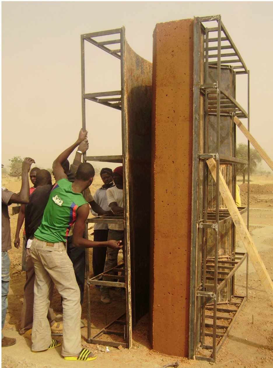
Lehm stampfen und pressen war gestern: Durch die leichte Rundung sind die einzelnen Wandelemente aus Lehm in sich stabil und ausgesteift. Hergestellt werden sie mit Hilfe eines zweiteiligen Schalungsmoduls aus Eisen. (Fotos: Francis Kéré)
