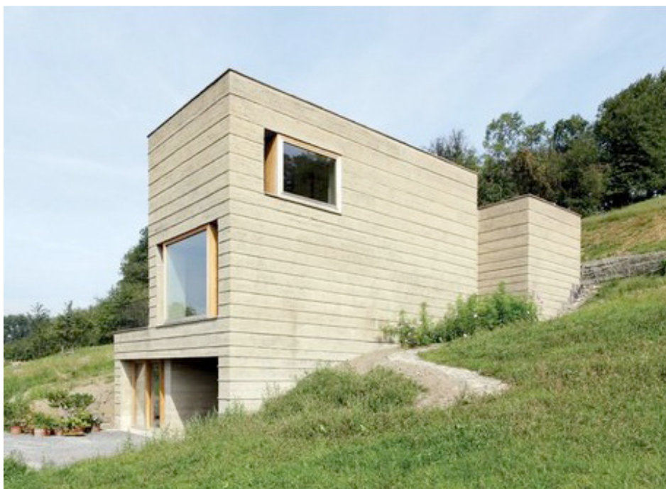
Haus Rauch: Dreigeschossiger Lehm- bau von Martin Rauch in Schlins, 2008 (Foto: M. Rauch)
