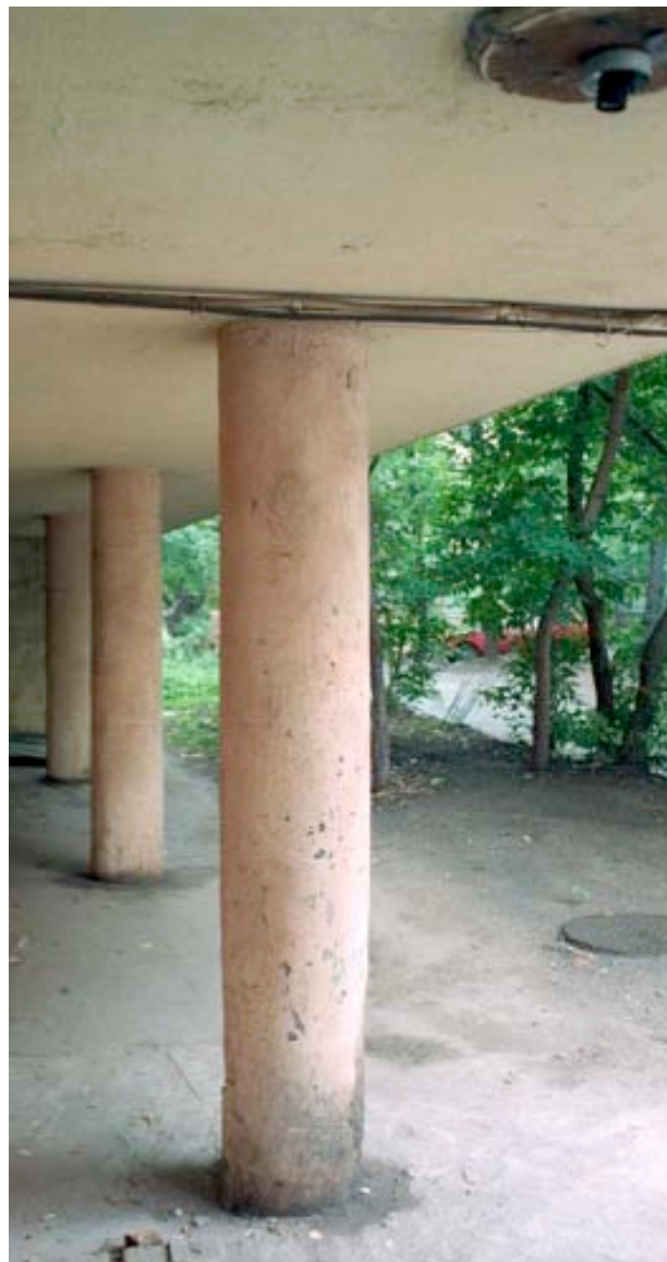
Das Erdgeschoss bestand ursprünglich aus runden Stahlbetonstützen, die ein Durchlaufen ermöglichten. Später wurde durch Einbauten diese Durchlässigkeit zerstört.
