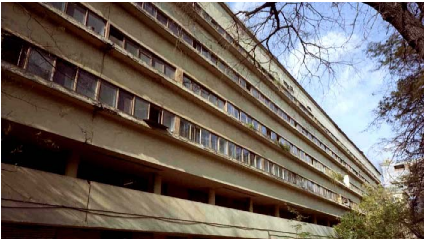
Horizontale Fensterbänder sollen einen freien Blick auf die umliegenden Grünflächen ermöglichen. (Foto: Richard Parel Kick-en Berlin)
