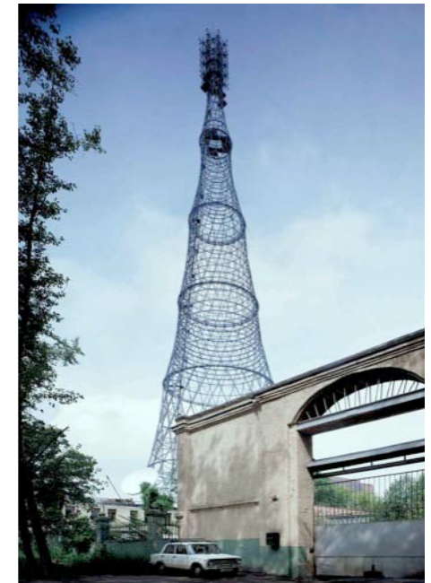
Ursprünglich sollte der Turm 350 Meter hoch werden. Aus Mangel aus Stahl konnten dann aber nur 150 Meter Höhe realisiert werden. (Foto: Richard Pare/ Kicken Berlin)
