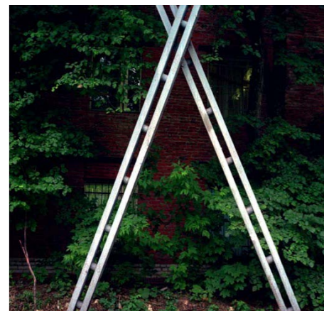
Aus der regelmäßigen Anordnung langer, gerader Fachwerkstäbe entsteht eine Netzkonstruktion, die ein Nachgeben oder Verbiegen des Materials verhindert.
