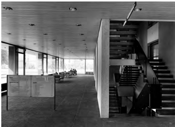
Das Zentrum des Rektorats bildet eine offene Treppenanlage, die schon 1960 aus Brandschutzgründen nicht genehmigungsfähig war. Sie wird jetzt um zwei geschlossene Treppenhäuser ergänzt. Die Flurwände mit Oberlichtern werden abgerissen. Fotos links und rechts: Heinrich Heidersberger, 1960. Foto Mitte: -tze
