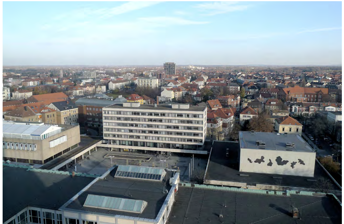
Blick vom Okerhochhaus auf das Dach des TU-Altgebäudes (im Vordergrund) und das Forum mit Bibliothek, Rektorat und Audimax. Foto: -tze
