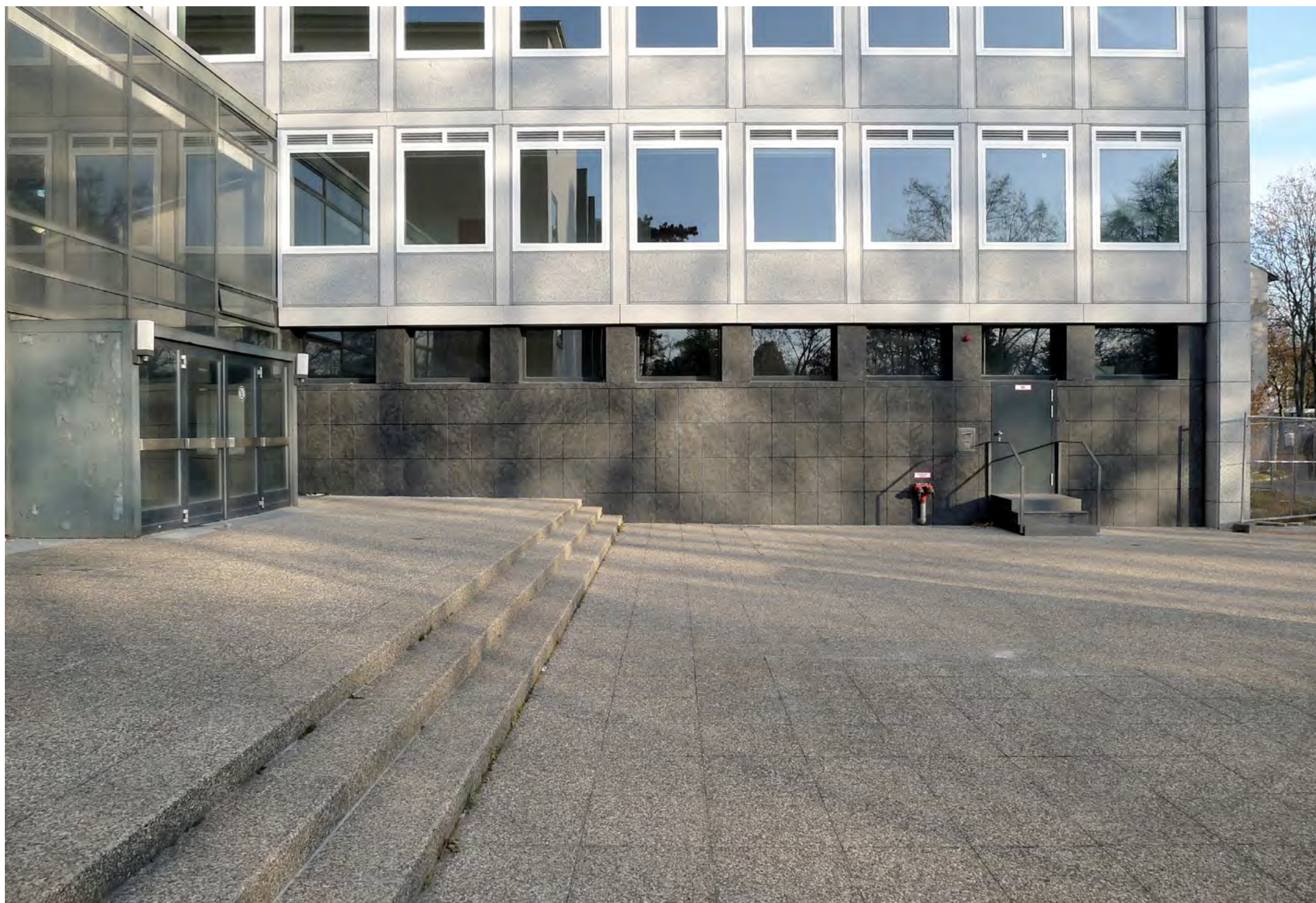
Der Eingang des Okerhochhauses. Die neue Fassade besteht aus einem gängigen Aluminium-Sandwichsystem, auf das die Oberflächen nur dünn appliziert wurden. Foto: -tze
