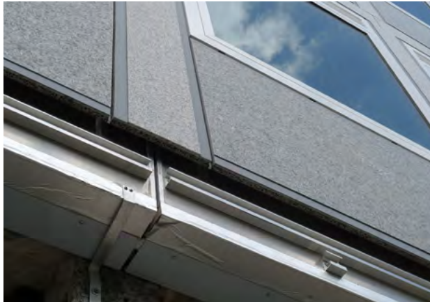
Nach der Sanierung: Fugen und Materialien sind nur simuliert
