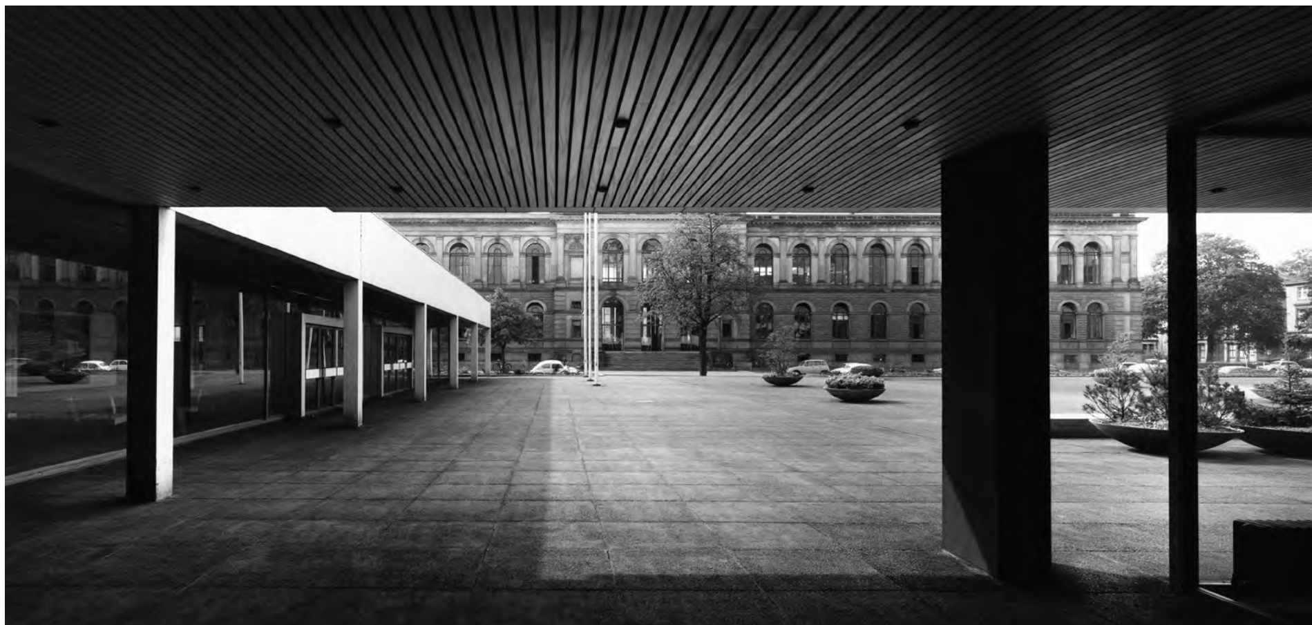
Blick vom Rektorat auf das Altgebäude der TU Braunschweig. Links der Eingang des Audimax. Architektur: Friedrich Wilhelm Kraemer, Foto: Heinrich Heidersberger, 1960. Vorige Seite: Foto -tze
