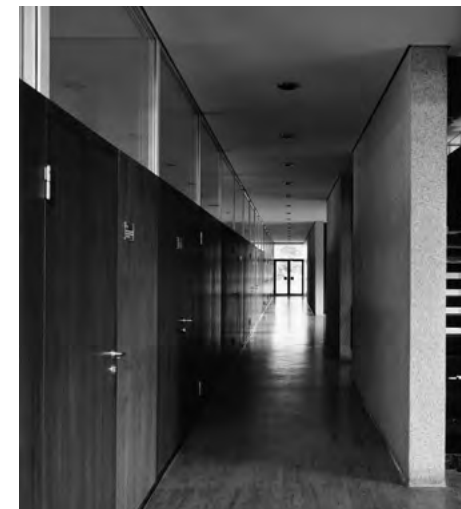
Das Zentrum des Rektorats bildet eine offene Treppenanlage, die schon 1960 aus Brandschutzgründen nicht genehmigungsfähig war. Sie wird jetzt um zwei geschlossene Treppenhäuser ergänzt. Die Flurwände mit Oberlichtern werden abgerissen. Fotos links und rechts: Heinrich Heidersberger, 1960. Foto Mitte: -tze
