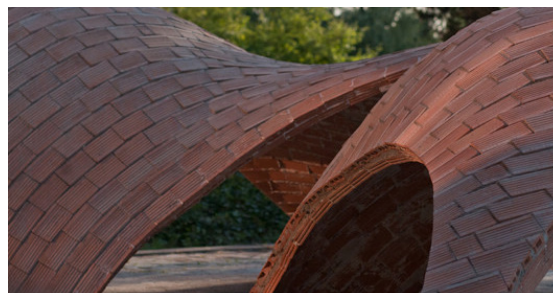
Prototyp eines Gewölbe-tragwerkes in Zürich/CH
