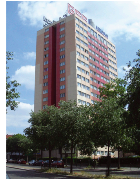
...nach der haustechnischen Sanierung 1990...
