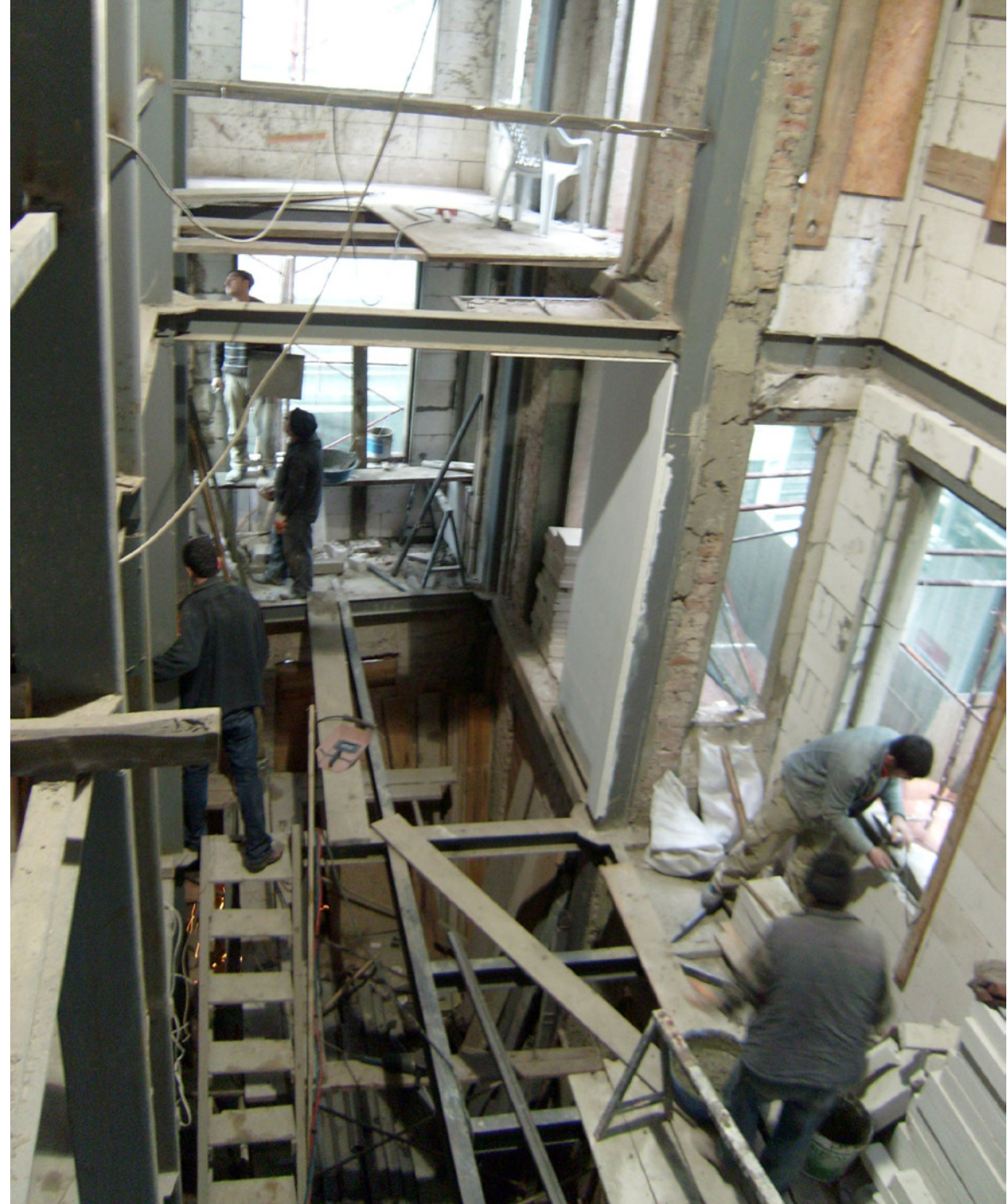
Aber auch auf der Baustelle wurden noch viele Entscheidungen direkt getroffen.
