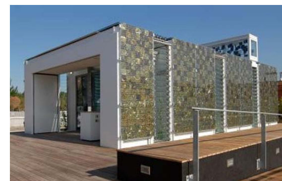
Solartechnik in und am Gebäude
