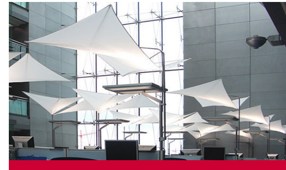
Deckensegel werden zur Verbesserung der Raumakustik eingesetzt
