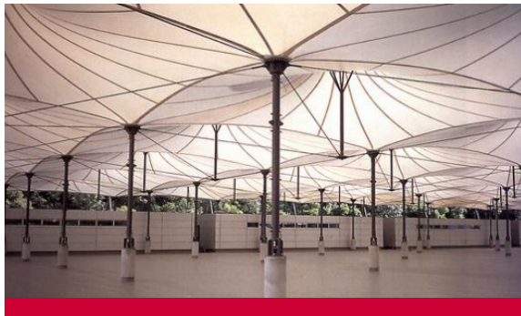
Segel als Membrankonstruktion beim Amt für Abfallwirtschaft
