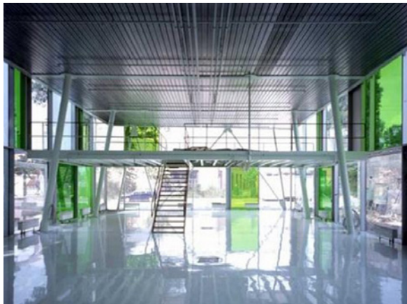
Fabrikations- und Verwaltungsgebäude in Köln
