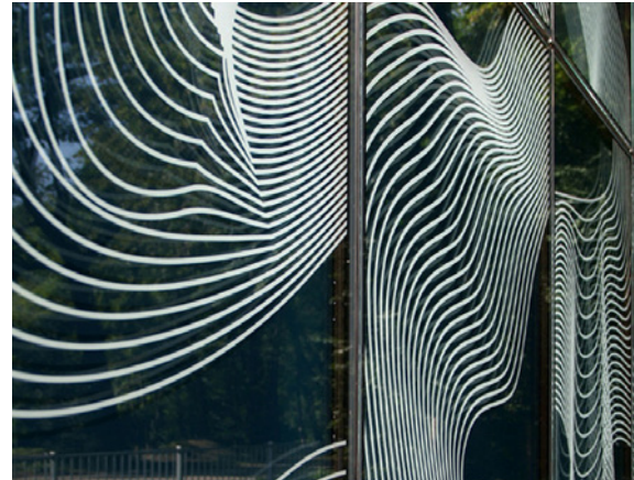
Wasserwerk am Hochablass in Augsburg
