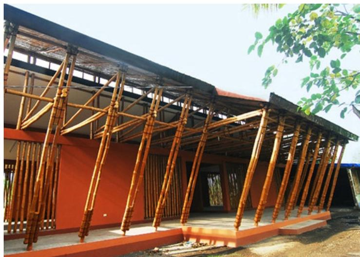
*Klassenräume in Camarines-Sur – Bambuskonstruktion*
