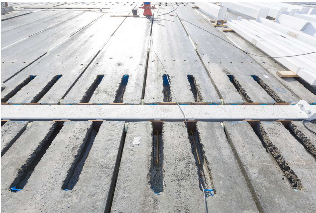
Freigelegte Verankerungen der Deckenelemente beim Rückbau des temporären Gerichtsbauwerks in Amsterdam. Foto: cepezed | Léon van Woerkom
