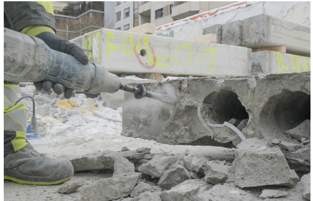
Rückbauarbeiten am Spendergebäude des Forschungsprojekts ReCreate in Tampere Fotos: Eetu Lehmusvaara
