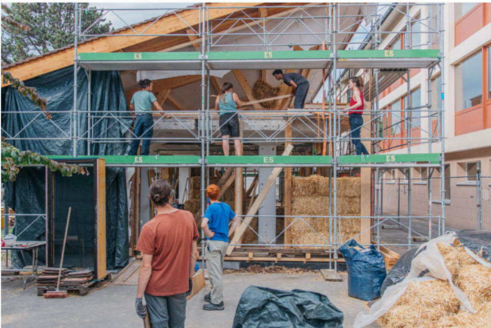
Von Renens (links oben) wurden die Betonteile per Sattelschlepper (rechts unten) nach Ecublens (links unten) transportiert. Dort befinden sie sich nun im Inneren des Empfängergebäudes, umhüllt von einer Holz- und Strohfassade. Fotos links oben und rechts unten: rebuiLT. Foto links unten: PJRenaud, rebuiLT
