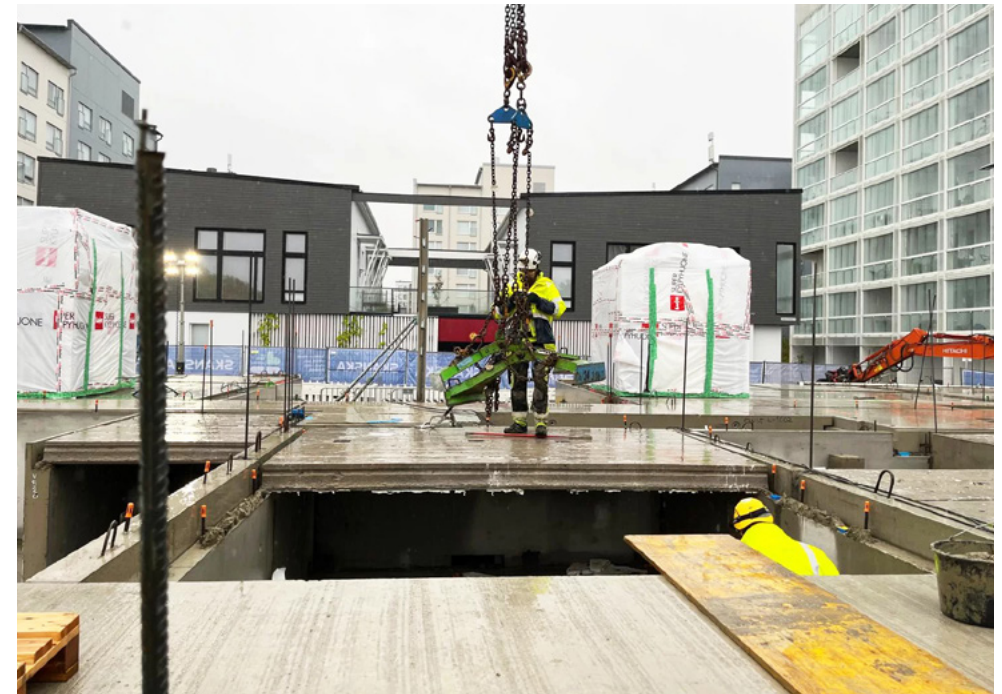
Links: Ein Hohldeckenelement zur Aufbereitung in der Fertigteilfabrik in Kangasala. Foto: Satu Huuhka
