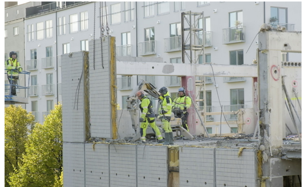
Das finnische Projektteam um Satu Huuhka (links unten) zerlegt ein 1982 errichtetes Bürogebäude im Zentrum von Tampere. Fotos: Eetu Lehmusvaara
