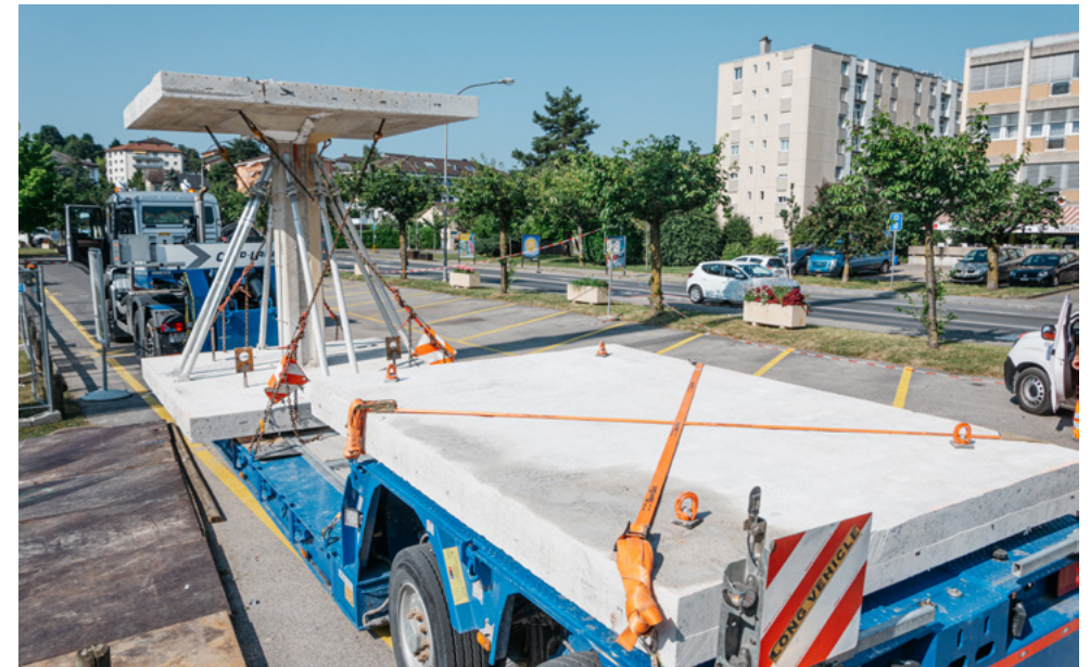
Von Renens (links oben) wurden die Betonteile per Sattelschlepper (rechts unten) nach Ecublens (links unten) transportiert. Dort befinden sie sich nun im Inneren des Empfängergebäudes, umhüllt von einer Holz- und Strohfassade. Fotos links oben und rechts unten: rebuiLT. Foto links unten: PJRenaud, rebuiLT
