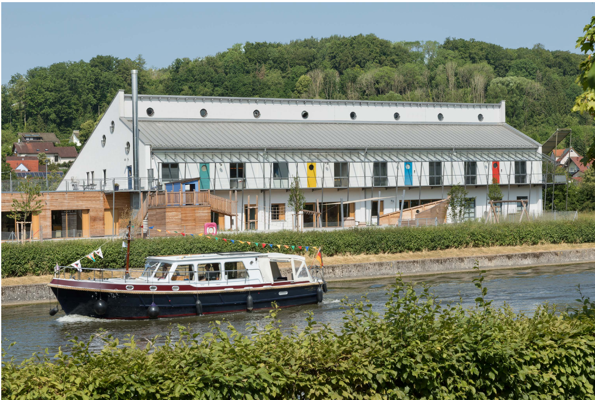
Die Kita St. Lorenz in Berching zog in einen ehemaligen Supermarkt, der direkt am Main-Donau-Kanal liegt. Die Spielgeräte sind von den Landschaftsarchitekt*innen des Studio B thematisch daran angelehnt. Die Planung für den Umbau stammt von Kühnlein Architektur. Foto: Erich Spahn
