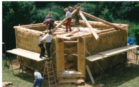
Strohballenbau in Kassel von Gernot Minke (2000). Foto: Gernot Minke
