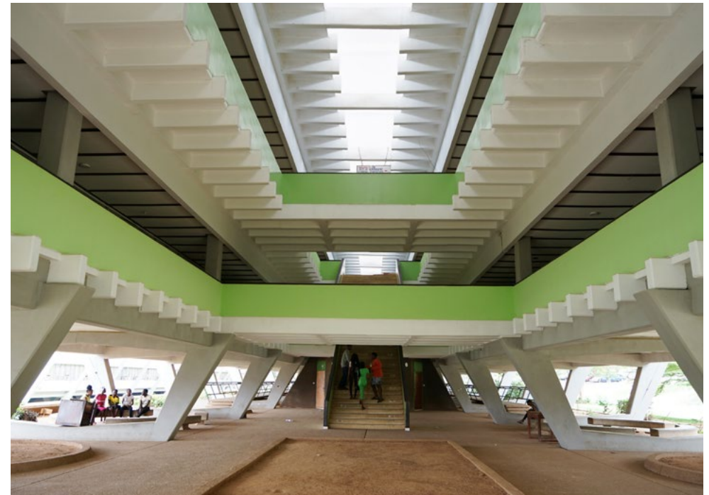
Offenes Erdgeschoss des Fakultätsgebäude für Jura mit Ausgang ins Obergeschoss. Foto: Brenne Architekten, 2022
