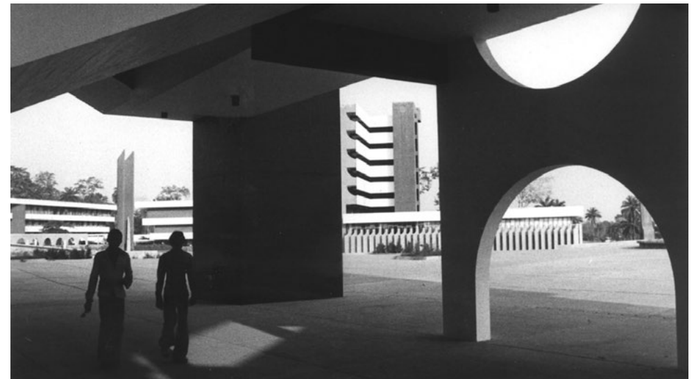
Laubengänge sowie überdachte Außenbereiche und Wege bieten Schutz vor Hitze und Monsunregen. Fotos: Yael Aloni Photo Collection, Courtesy of the Azrieli Architectural Archive, Arie and Eldar Sharon Collection, 9650005
