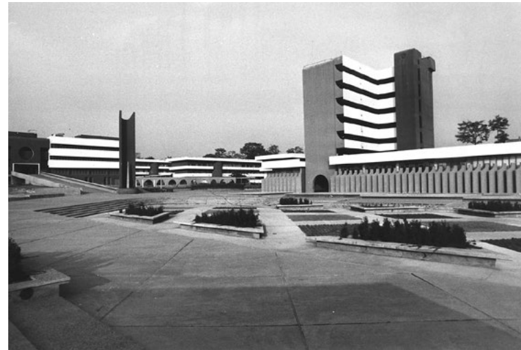
Rechts: Blick über den zentralen Platz, links die Bibliothek, rechts die Assembly Hall. Foto: Yael Aloni Photo Collection, Courtesy of the Azrieli Architectural Archive, Arieh and Eldar Sharon Collection, 9650005
