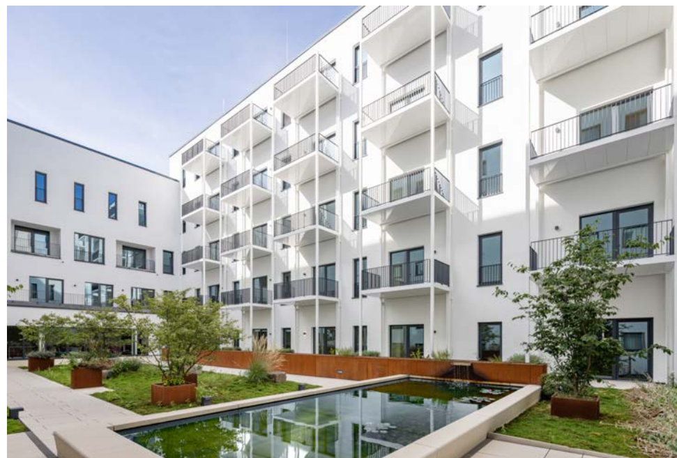
Umbau des ehemaligen Althoff Warenhauses von 1930 in Recklinghausen zum gemischt genutzten Quartier nach Plänen von AIP Planungs GmbH. Rechts: Blick in den neu eingeschnittenen Lichthof, an dem die betreuten Seniorenwohnungen liegen. Fotos: Marcel Kusch
