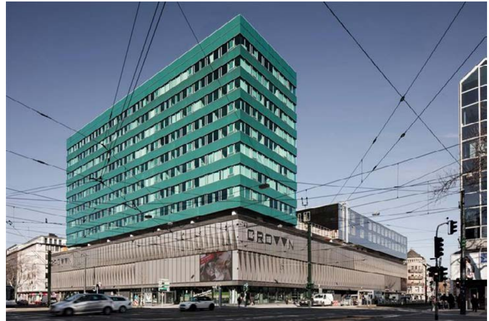
Aus der alten Galeria Kaufhof an der Berliner Allee in Düsseldorf wurde schon 2018 „The Crown“, eine Kombination aus Feinkost-Supermarkt, Gastronomie und Drei-Sterne-Hotel. Das Architekturbüro RKW+ baute dabei einen Entwurf seines Gründers Helmut Rhode aus den 1950er-Jahren um. Fotos: Bildarchiv RKW+, Marcus Pietrek (nachher), Bild: RKW+
