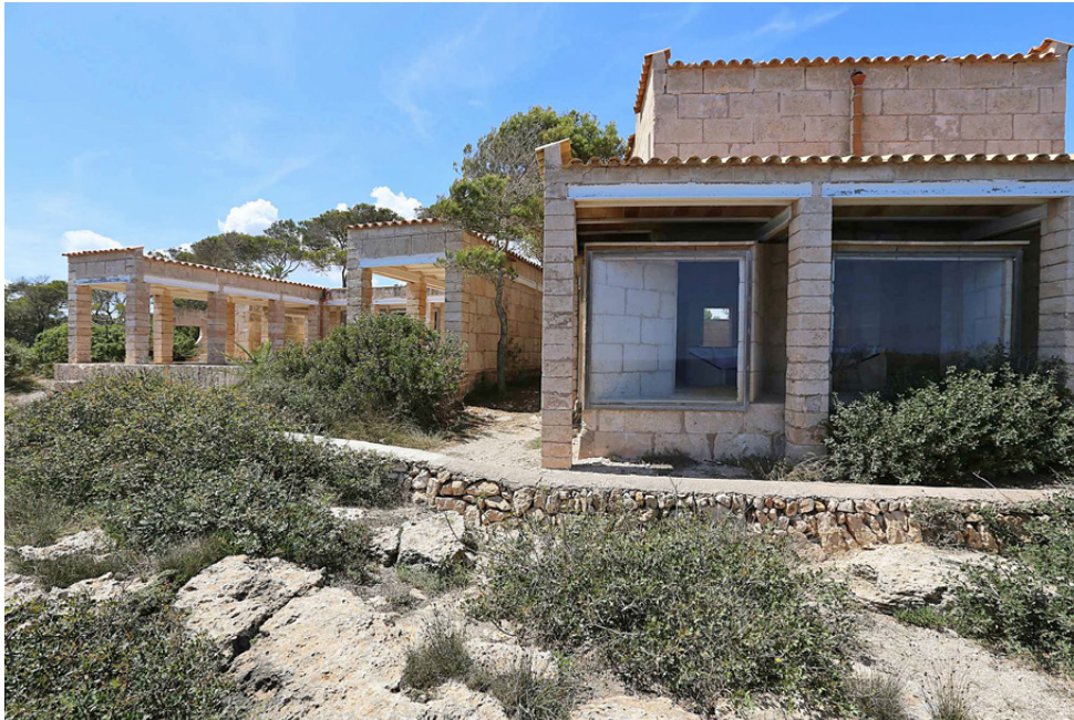
Pionierbau hinsichtlich der zeitgenössischen Nutzung des Marès-Steins: Die Villa Can Lis von Jørn Utzon wurde 1972 in der Gemeinde Santanyi fertiggestellt. Passenderweise trägt die Straße, an der das Haus steht, inzwischen Utzons Name. Fotos (diese und nächste Seite): Klaus Englert
