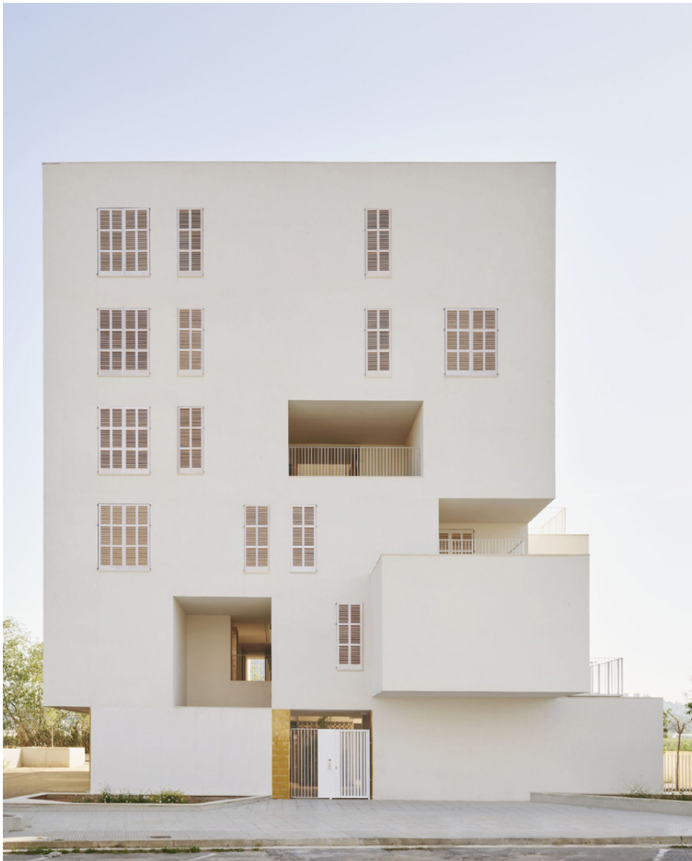
Kompakt, aber durchlässig: IBAVI-Wohnkomplex in der Xarc-Straße in Ibiza (Stadt), entworfen und im Jahr 2022 von RipollTizon Estudio de Arquitectura fertiggestellt. Fotos: José Hevia
