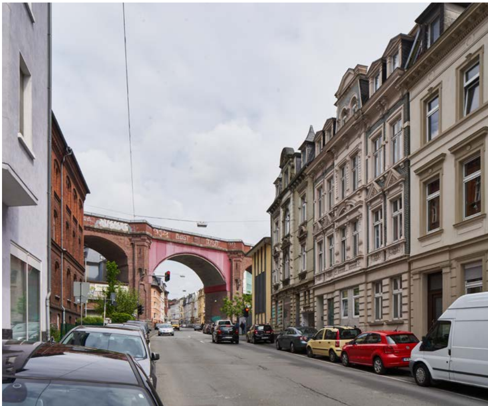
Dass die Nordbahntrasse auch ein riesiges Bauwerk ist, zeigt sich hier am Wichlinghauser Viadukt. Foto: Jan Kampshoff
