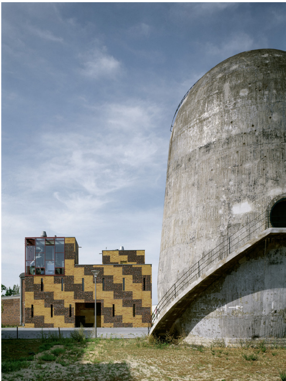
Gefahrstofflager der Humboldt-Universität in Berlin Adlershof, Benedict Tonon mit Caroline Thielemann und den Ingenieuren igh Höpfner. Bauleitung Peter Flucke, Fertigstellung 2002. Foto: Werner Huthmacher
