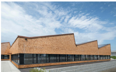
Foto: Rainer Retzlaff / F64 Architekten
