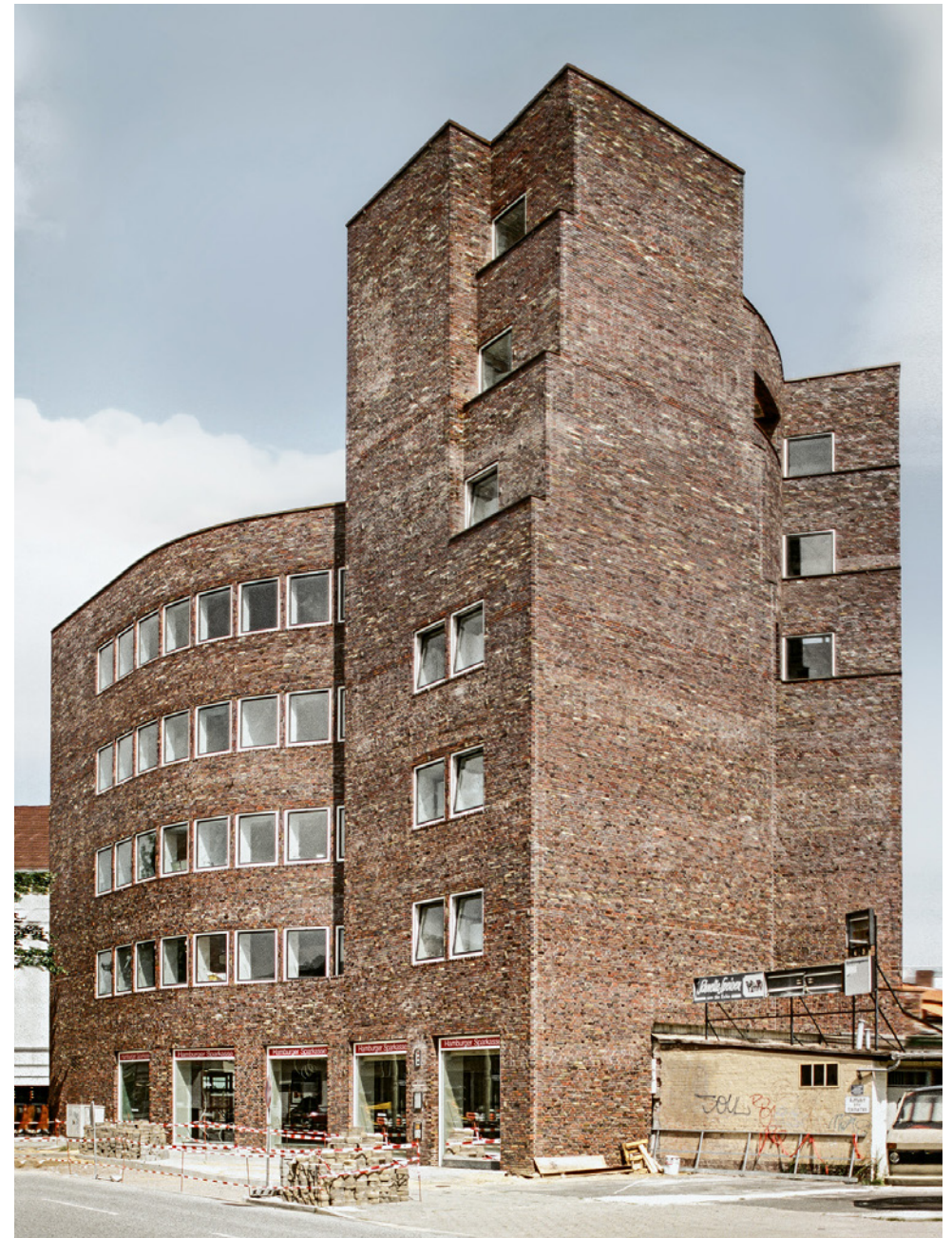
Sparkasse Barmbeck in Hamburg, Benedict Tonon mit Götz Hinrichsen, Dorothee Grundmann und den Ingenieuren Carlsen-Glusing-Kliche, Fertigstellung 1994, Foto: Tom Schoper
