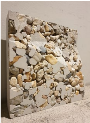
Die Installation Two Walls (2020) markiert den temporären Eingang zum Berliner Haus am Waldsee und zur Ausstellung „Revolutions of Choice“ von Barkow Leibinger. Die Arbeit besteht aus zwei in Sand und Fels gegossenen Betonwänden mit stark strukturierten Oberflächen. kleine Fotos: Barkow Leibinger, großes Foto: Simon Menges
