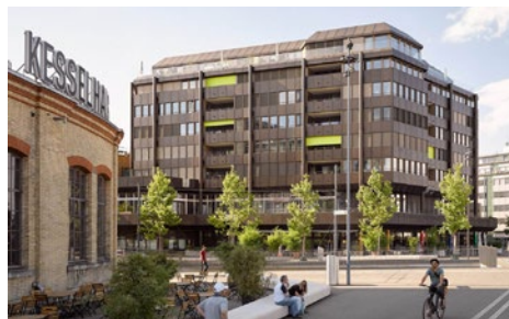
Bürotransformation von Häberli Heinzer Steiger Foto: Michael Haug
