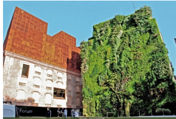
Begrünung einer Brandwand am Caixa Forum in Madrid nach Plänen von Patrick Blanc. Foto: Patrick Blanc
