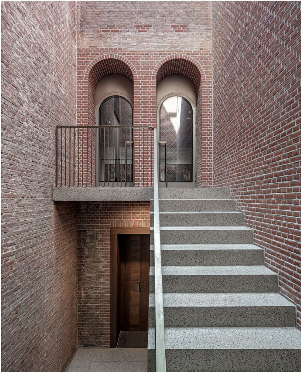
Nahtstelle von Alt und Neu im Museum „de Lakenhal“ in Leiden, Umbau und Erweiterung von Happel Cornelisse Verhoeven, 2020. Foto: Karin Borghouts
