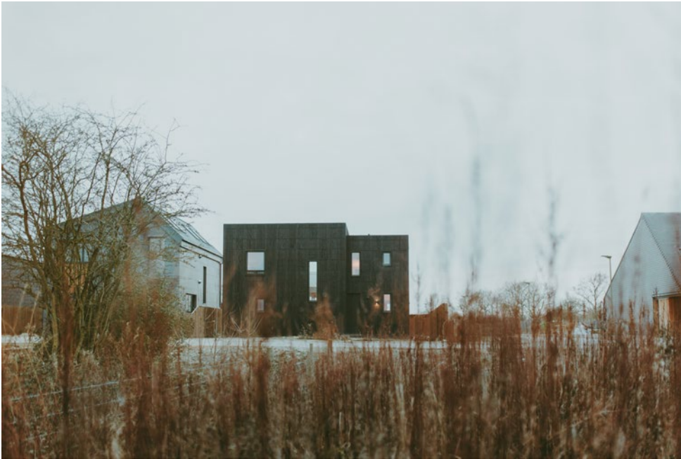
Das Box House entstand auf Grundlage des U-Build-Systems als Teil einer größeren Selbstbau-Initiative. Fotos: Lenny Codd
