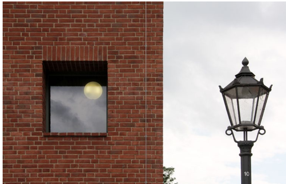
Die Außenwände der Mittelpunktsbibliothek von Bruno Fioretti Marquez Architekten sind bis zu 64 Zentimeter stark. Foto: Matthias Frey
